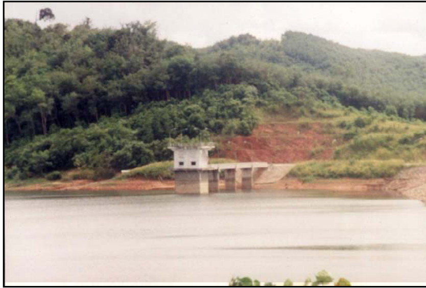
ภาพประกอบ 2-4 ลักษณะอาคารระบายน้ำของเขื่อนคลองสะเดา
