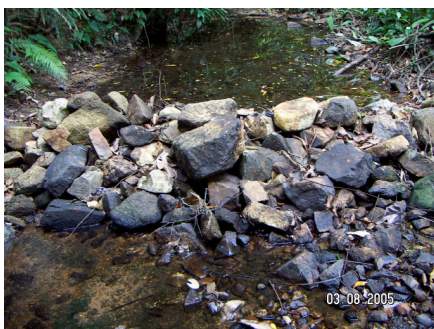
ภาพประกอบ 10-11 ธนาคารน้ำแบบใช้หิน
