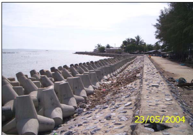
รูปที่ 1-3 สภาพกำแพงกันคลื่นและก้อนคอนกรีต บริเวณบ้านบางตาวา
