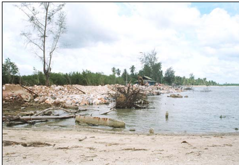
รูปที่ 1-2 การก่อสร้างกำแพงกันคลื่นและแนวหินทิ้งบริเวณหาดรัชดาภิเษก
