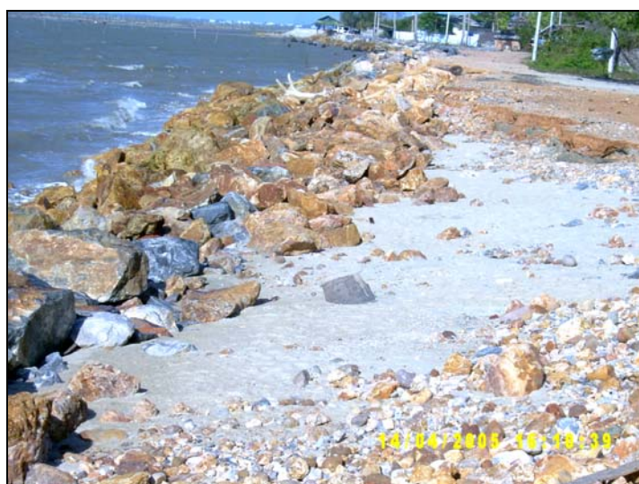
รูปที่ 2 สภาพการกัดเซาะและแนวหินทิ้งป้องกันชายฝั่งบ้านบะอิ่ง (หาดรัชดาภิเษก)
