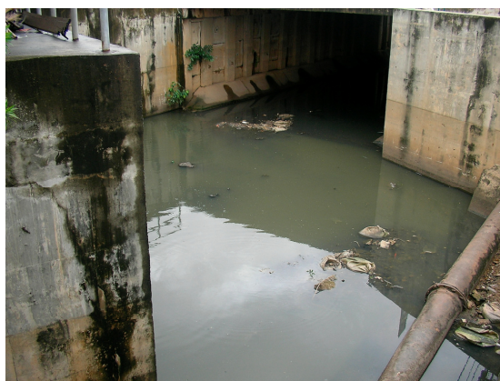
ภาพประกอบภาคผนวก 2 แหล่งน้ำที่ 2 ซึ่งเป็นน้ำสกปรกปานกลาง (BOD 40-60 มิลลิกรัม/ลิตร)
