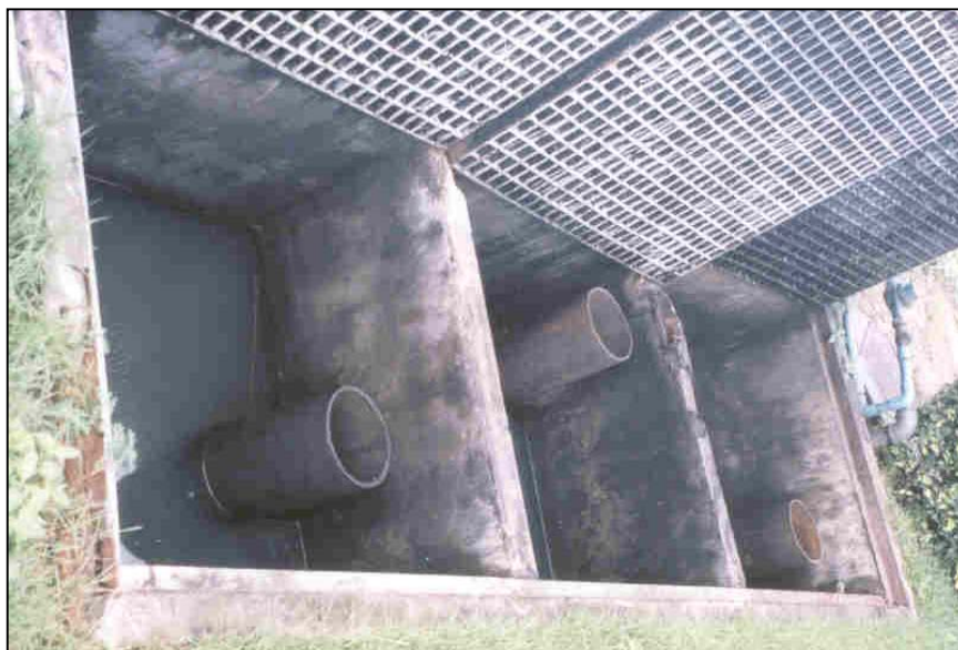
ภาพประกอบผนวก 10 บ่อดักน้ำมันและไขมันที่ไม่ได้ดำเนินการดักน้ำมันและไขมัน
