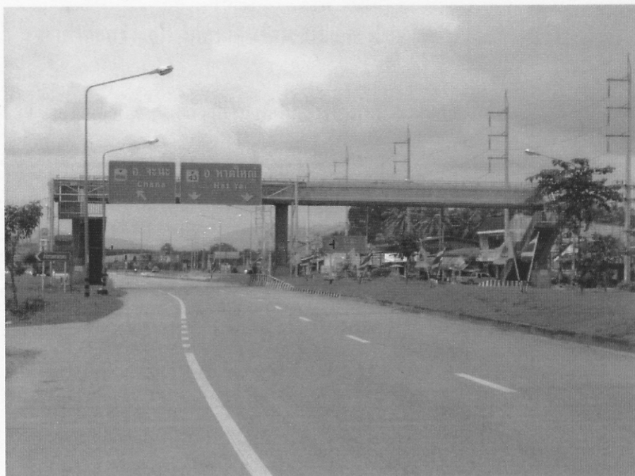
ภาพประกอบที่ 4.7 : สะพานลอยคนเดินข้ามตั้งอยู่ก่อนถึงทางแยกเข้าอำเภอจะนะ
