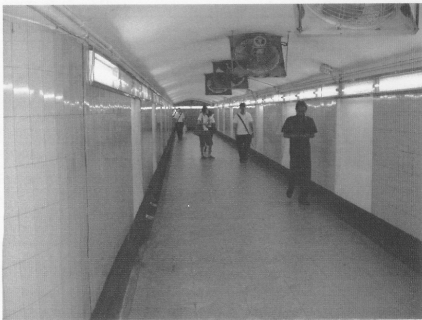
ภาพประกอบที่ 4.10 : สภาพภายในอุโมงค์คนเดินข้ามซึ่งจะต้องมีไฟเปิดตลอดเวลา
