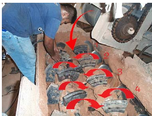
ภาพประกอบ 3.7 ลักษณะการติดตั้งและตำแหน่งของไบผสมดินในเครื่องผสมดิน
