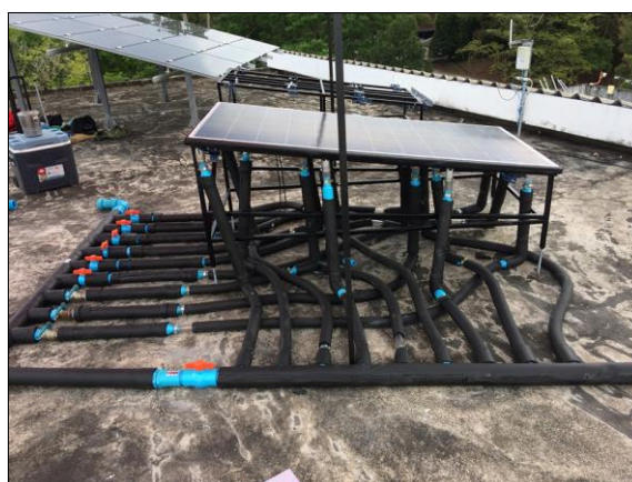
(ข) ระบบท่อน้ำเข้า-ออกที่ต่อกับกับแผง PV/T
