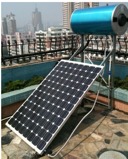
รูปที่ 2.23 ระบบแผง PV/T ที่ติดตั้งเพื่อผลิตไฟฟ้าและน้ำร้อน [9]
