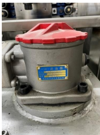
ภาพที่ 4.39 กรองน้ำมันไฮดรอลิก
