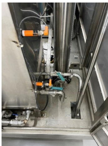
ภาพที่ 4.23 ตัวอย่างเซนเซอร์ (Sensor) วัดระดับน้ำในถังพัก
