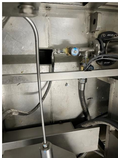
ภาพที่ 4.5 พื้นที่เครื่องจักรใต้ท่อบนน้ำ
