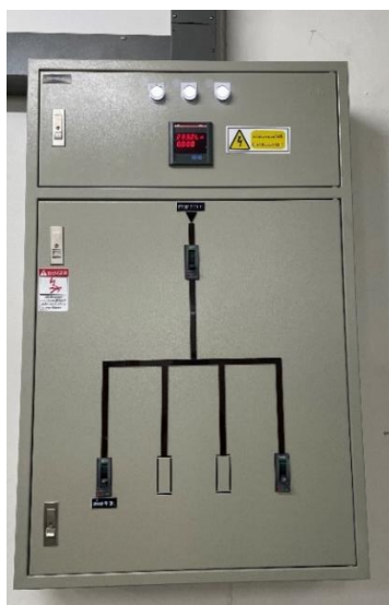
ภาพที่ 4.16 ตู้จ่ายไฟย่อย DB-HPP-80
