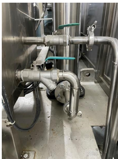
ภาพที่ 4.32 ชุดกรอง (Y-Strainer)
