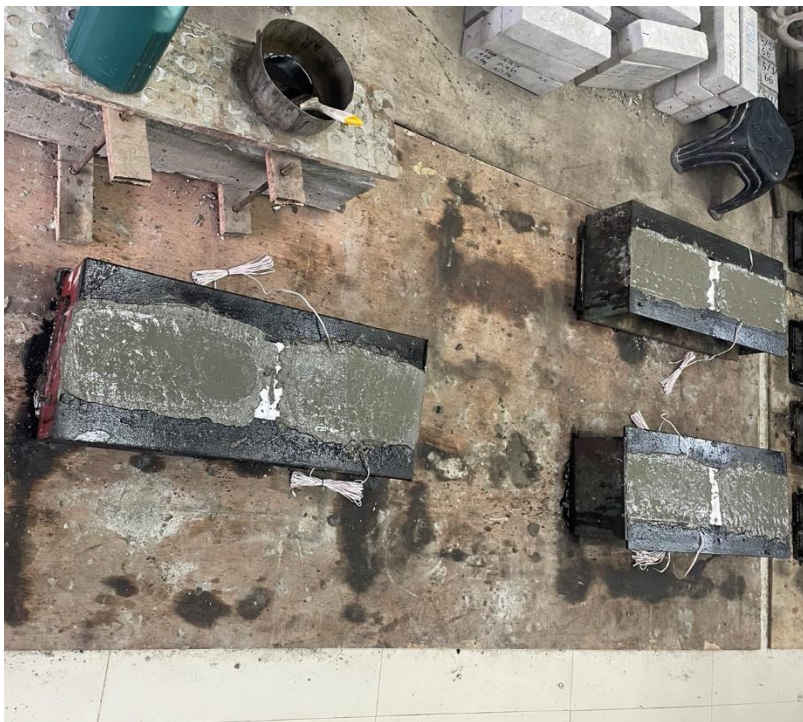
รูปที่ 3.12 การนำคอนกรีตใส่ลงในแบบหล่อ
