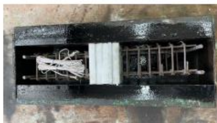
รูปที่ 3 การเตรียมวัสดุก่อนหล่อคาน
