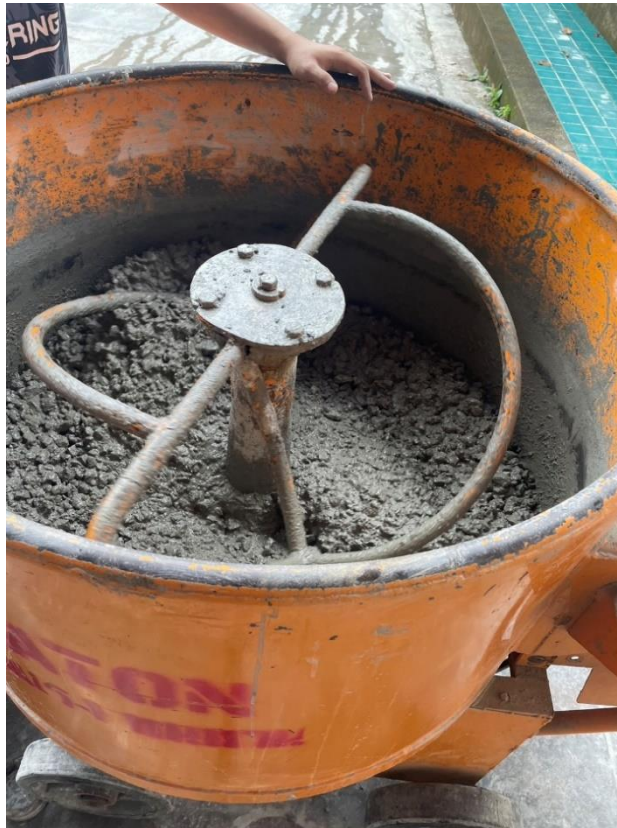
รูปที่ 3.10 การผสมคอนกรีต
