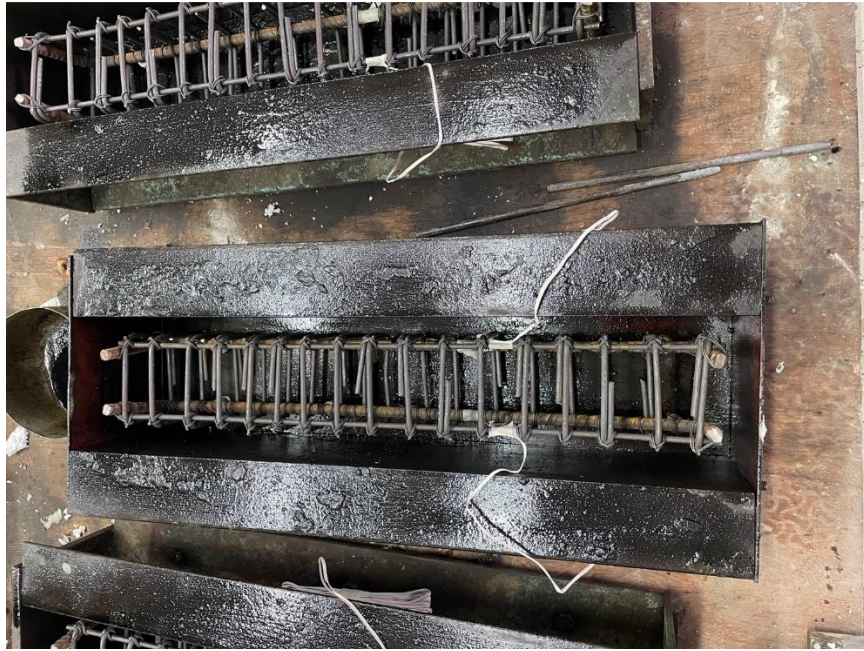
รูปที่ 3.8 การใส่เหล็กเสริมลงในแบบ
