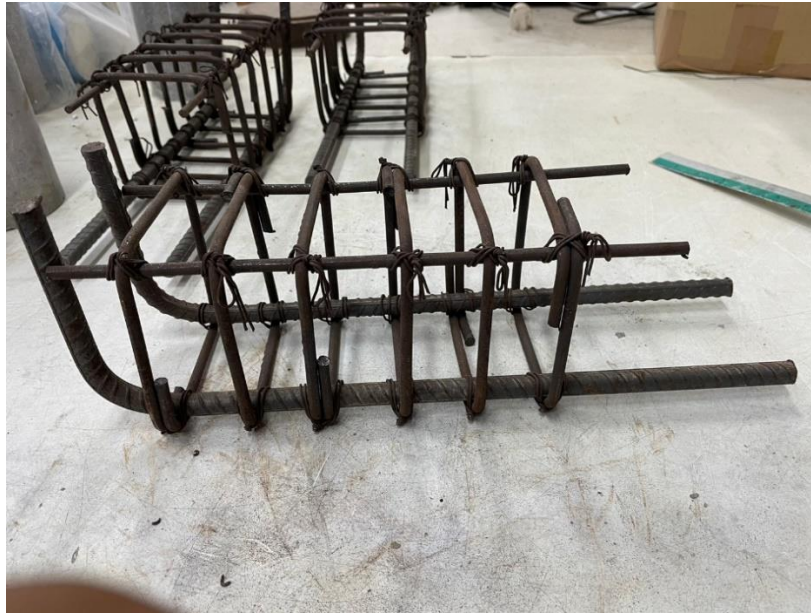
รูปที่ 3.6 การผูกเหล็กเสริม
