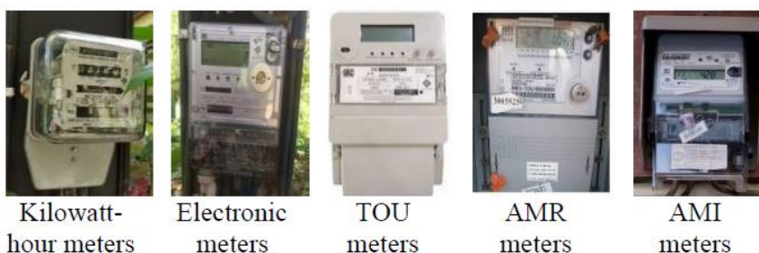
ภาพประกอบที่ 2-7 ประเภทมิเตอร์ที่มีติดตั้งใช้งานใน กฟภ.
