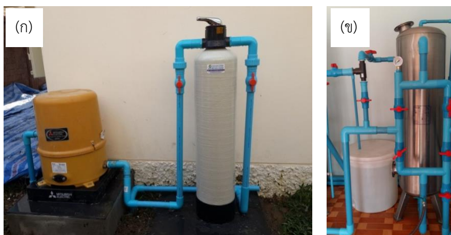
รูปที่ 2.1 ถังกรองน้ำแบบไฟเบอร์กลาส (ก) และถังแบบสแตนเลส (ข) ที่มา: หจก.แอล เอส วอเตอร์ เจ เทคโนโลยี (ประเทศไทย)
