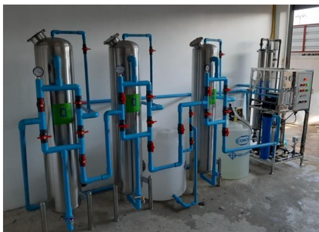
รูปที่ 2.2 ระบบกรองน้ำแบบถังกรอง (Filtration System) ที่มา: (หจก.แอล เอส วอเตอร์ เจ เทคโนโลยี(ประเทศไทย), 2566)
