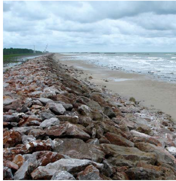
ภาพที่ 55 เขื่อนกันคลื่นแบบหินกอง บริเวณชายฝั่งแหลมหลวงรีสตอร์ท ต.แหลมผักเบี้ย อ.บ้านแหลม จ.เพชรบุรี
