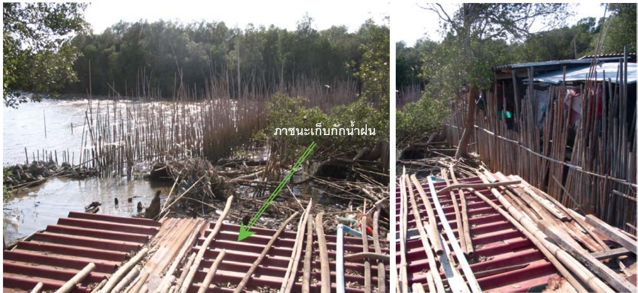
ภาพที่ 40-41 ภาชนะเก็บกักน้ำฝนของชุมชนบ้านแสมขาว หมู่ที่ 3 ต.สองคลอง อ.บางปะกง จ.ฉะเชิงเทรา ซึ่งสร้างด้วยการก่ออิฐเป็นบ่อรูปสี่เหลี่ยม และปิดด้วยหลังคากระเบื้อง
