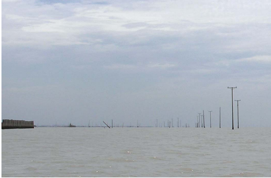
ภาพที่ 8 แนวเสาไฟฟ้าในเขตบ้านขุนสมุทรจีน ต.แหลมฟ้าผ่า อ.พระสมุทรเจดีย์ จ.สมุทรปราการ
