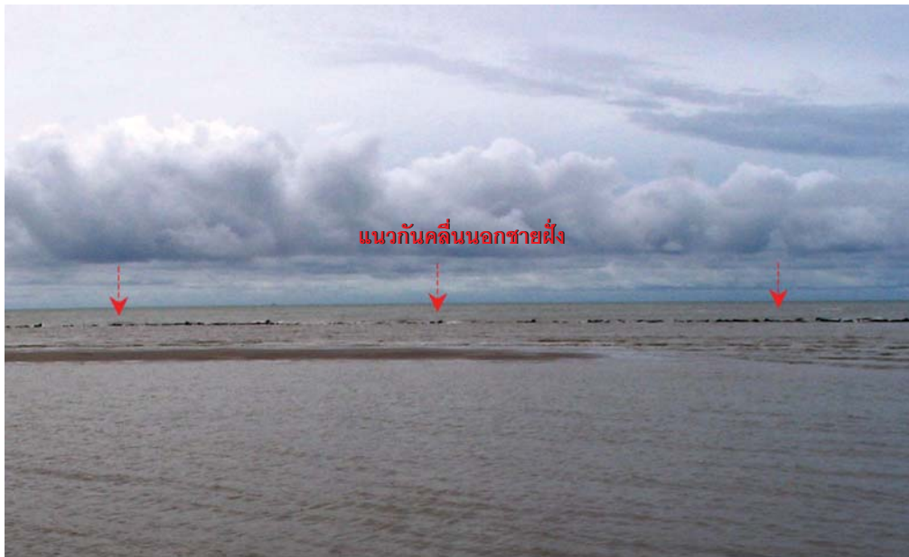
ภาพที่ 57 แนวกันคลื่นนอกชายฝั่งบริเวณพระราชานิเวศมฤคทายวัน ต.นาพันสาม อ.ชะอำ จ.เพชรบุรี
