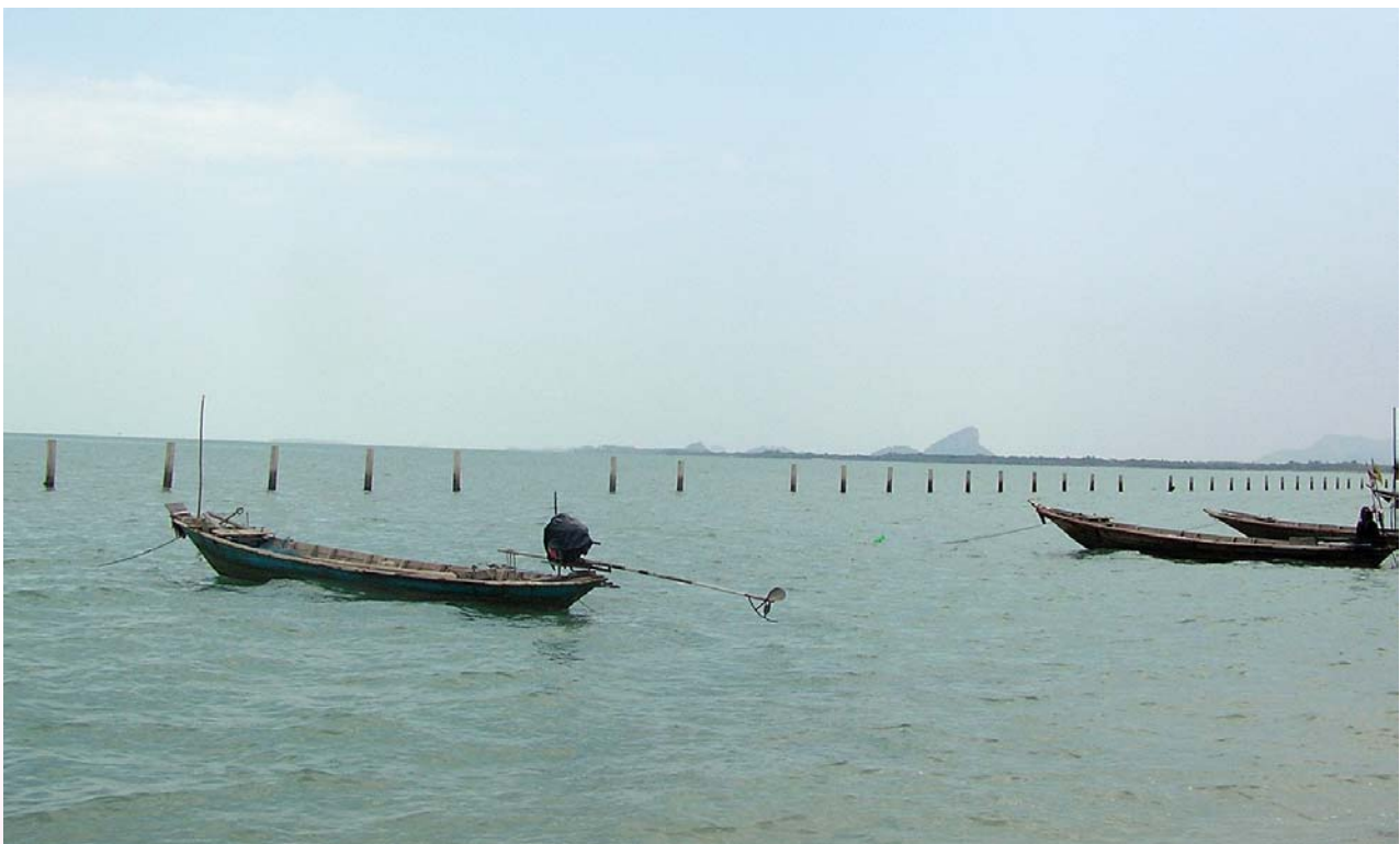
ภาพที่ 56 เขื่อนกันคลื่นแบบเสาเข็ม บริเวณชายฝั่งบ้านพอด ต.ชลคราม อ.ดอนสัก จ.สุราษฎร์ธานี
