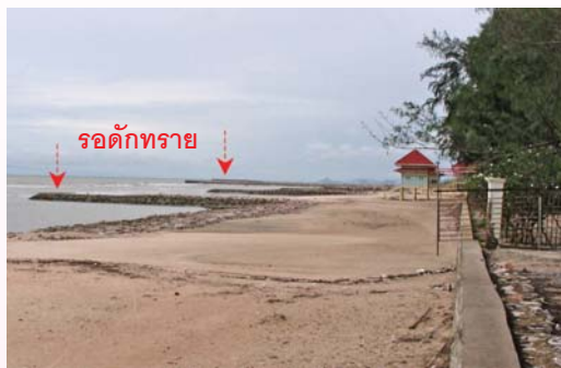
ภาพที่ 62 กำแพงกันคลื่นแบบขั้นบันไดบริเวณชายฝั่งวัดอัมพาราม ต.นาจอมเทียน อ.สัตหีบ จ.ชลบุรี
