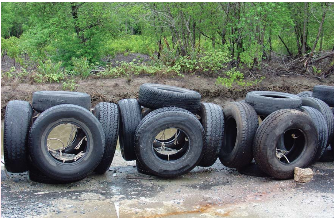
ภาพที่ 68 “เต่ายาง” ที่ชาวบ้านเป็ดใน ต.ห้วงน้ำขาว อ.เมือง จ.ตราด ใช้ในการป้องกันการกัดเซาะชายฝั่ง
