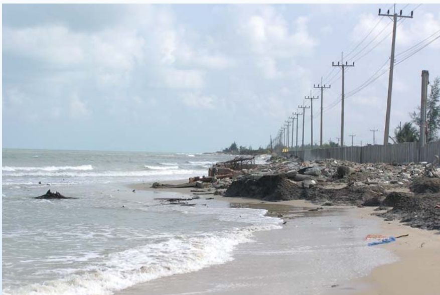
ภาพที่ 47 กำแพงกันคลื่น บริเวณชายฝั่งบ้านหน้าโกฏิต ต.ขนานนาก อ.ปากพนัง จ.นครศรีธรรมราช
