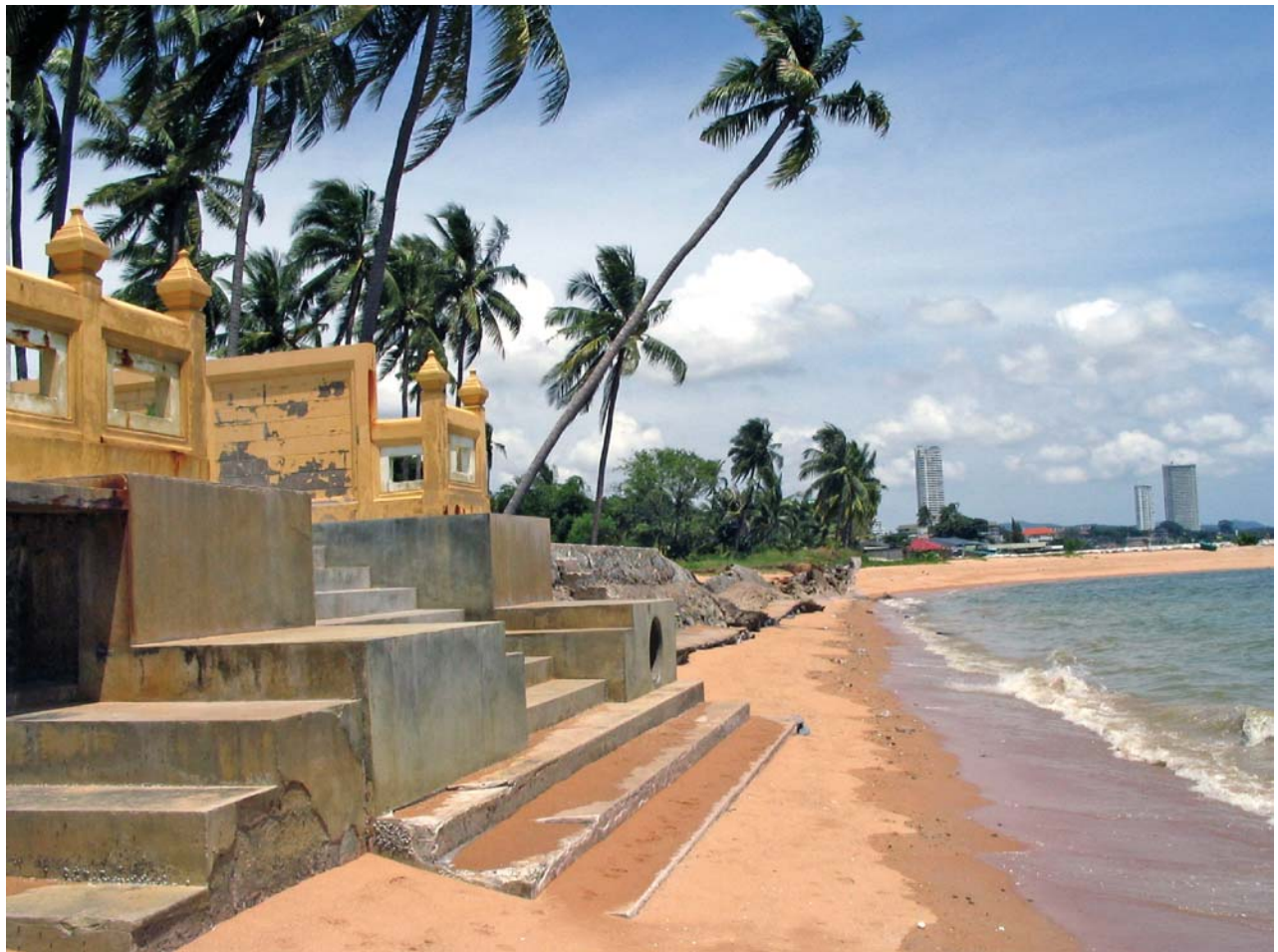
ภาพที่ 62 กำแพงกันคลื่นแบบขั้นบันไดบริเวณชายฝั่งวัดอัมพาราม ต.นาจอมเทียน อ.สัตหีบ จ.ชลบุรี
