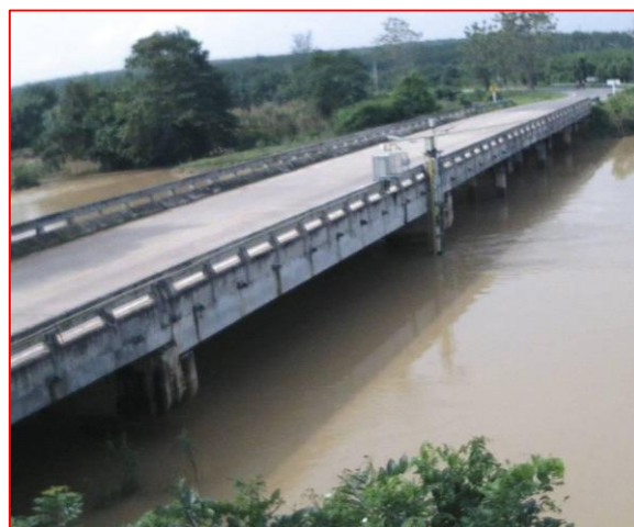
สถานีบ้านม่วงก้อง - อ.สะเดา จ.สงขลา (ลุ่มน้ำทะเลสาบสงขลา)
