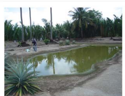
การประเมินสถานภาพและประสิทธิภาพระบบบำบัดน้ำเสีย
