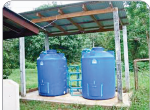
รูปที่ 4 ถังหมักขยะมูลฝอยอินทรีย์ที่โรงเรียนวัดชคามคชทวีป
