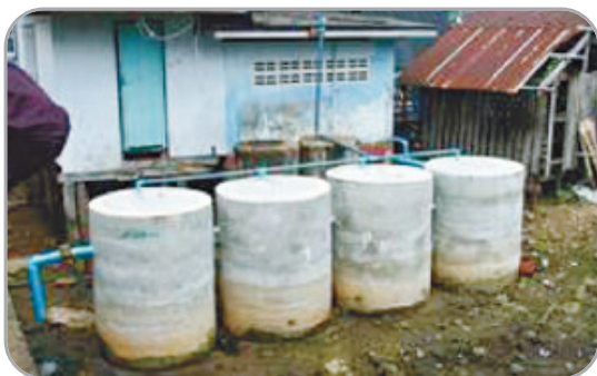
รูปที่ 2 ระบบบำบัดน้ำเสียแบบไร้อากาศร่วมกับถังดักไขมันมีผนังกัน บริเวณเกาะช้าง จังหวัดตราด
