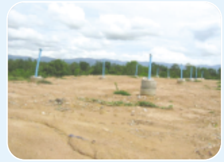
รูปที่ 3 ระบายก๊าซจากสถานที่ฝังกลบขยะมูลฝอย
