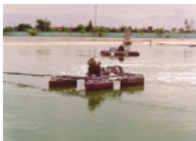
รูปที่ 4 ระบบบำบัดน้ำเสียแบบบ่อเติมอากาศ (เทศบาลเมืองพิจิตร)
