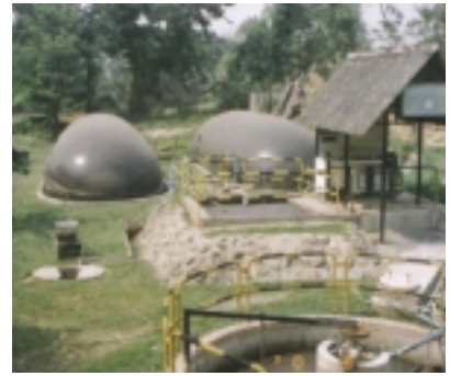
รูปที่ 5 ระบบบำบัดน้ำเสียก๊าซชีวภาพแบบ plug flow + UASB
