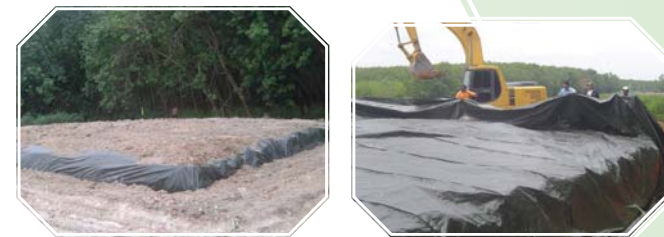
การปิดคลุมหลุมฝังกลบชั่วคราวด้วยแผ่นพลาสติก
