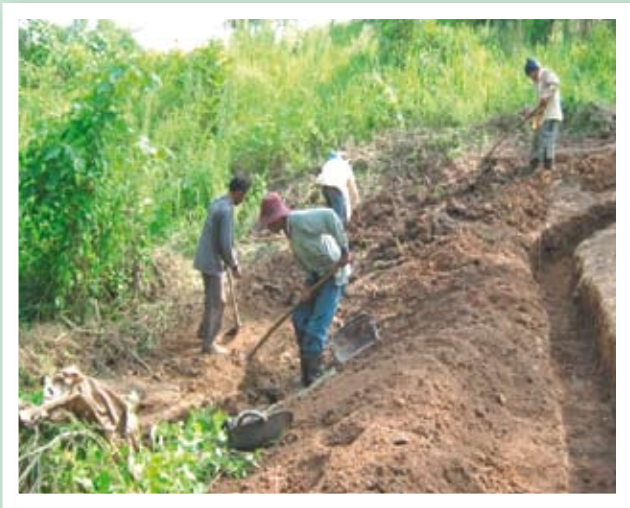
ทำคันดินเขียงทางไหลบอบน้ำ
