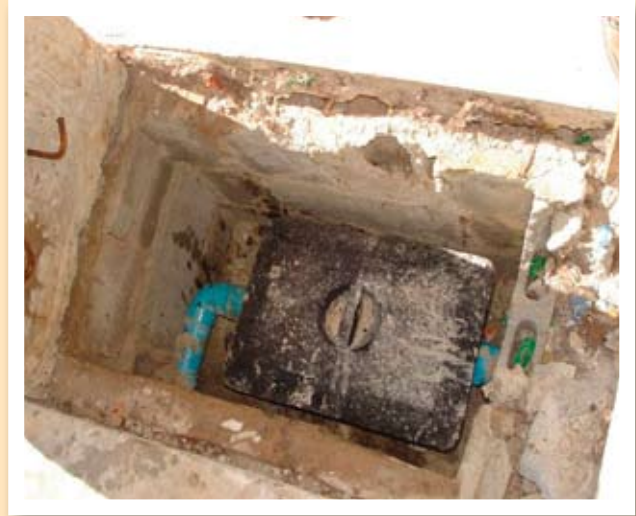
การตัดทับถังดักไขมัน ที่ยากต่อการจัดเก็บกากไขมัน
