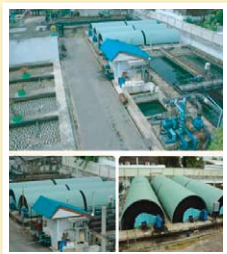
ระบบแผ่นหมุนชีวภาพ (Rotating Biological Contactor: RBC)
