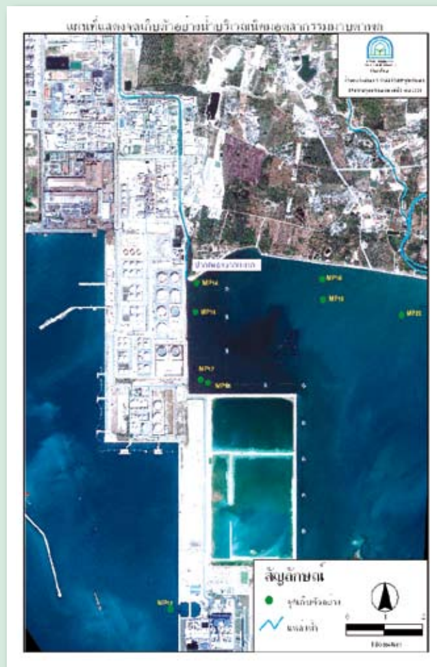
แผนที่แสดงจุดเก็บตัวอย่างน้ำ บริเวณนิคมอุตสาหกรรมมาบตาพุด
