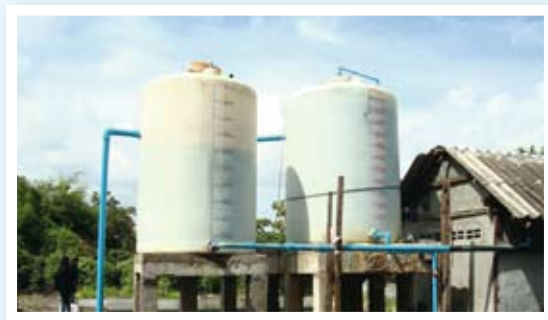
การติดตั้งระบบไอโซน
