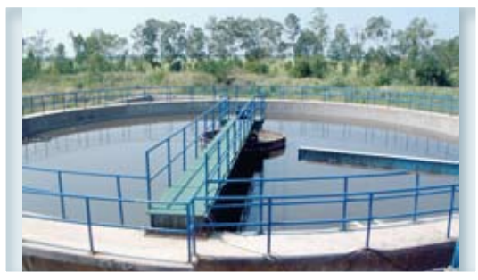
ระบบบำบัดแบบ Activated Sludge
