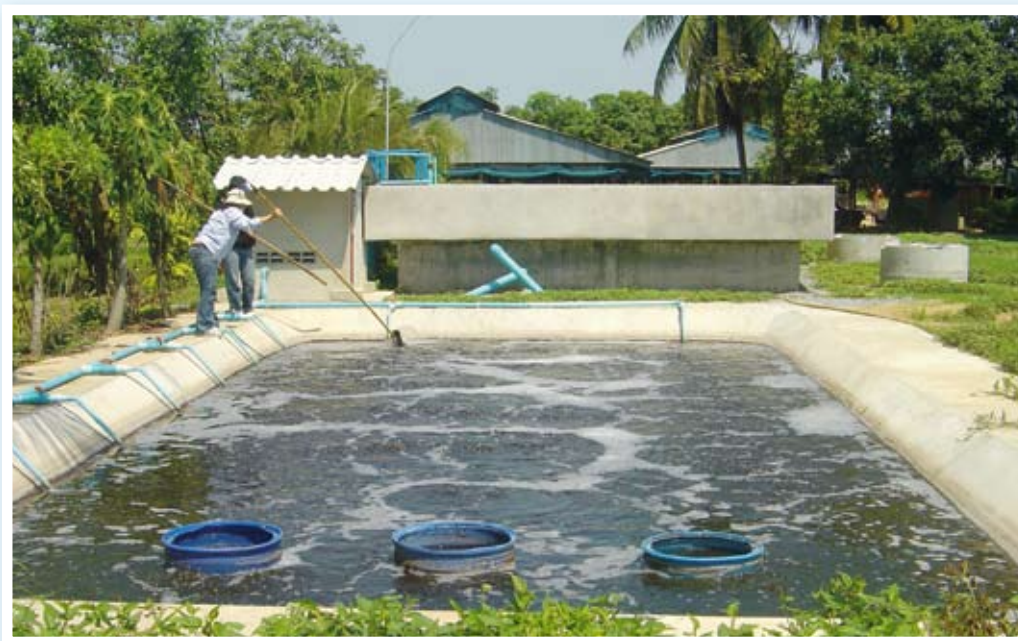
การติดตามประเมินประสิทธิภาพของระบบบำบัดน้ำเสียแบบ ABR
