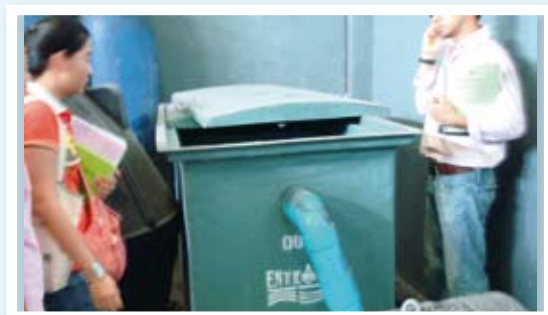
ติดตั้งถังดักไขมัน
