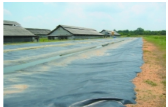
ระบบบำบัดน้ำเสียแบบพลาสติกคลุมบ่อ
