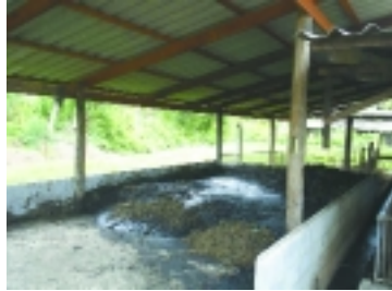
บริเวณกองมูลสุกรที่ดี มีหลังคาและพื้นซีเมนต์
