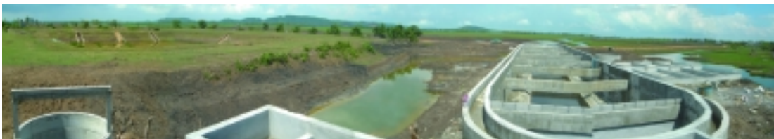
การก่อสร้างระบบบำบัดน้ำเสียรวมฟาร์มสุกร ต.ท่าหิน จ.สงขลา
