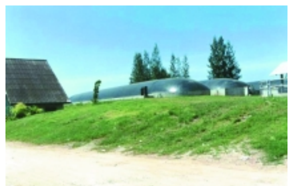
ระบบบำบัดน้ำเสียแบบก๊าซชีวภาพ
