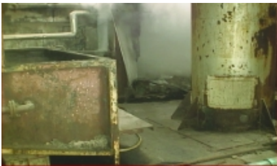
สภาพท่อน้ำก่อนหุ้มฉนวน
