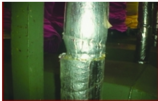
การหุ้มฉนวนท่อน้ำลดการสูญเสียพลังงาน
