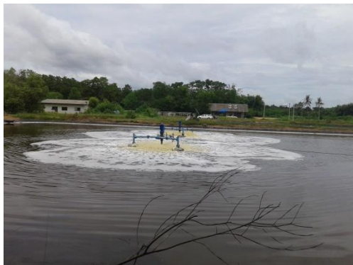
รูปที่ 4.1-22 ระบบบำบัดน้ำชะขยะมูลฝอย
