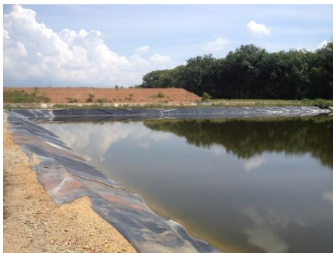
รูปที่ 4.5-12 ระบบบำบัดน้ำชะขยะมูลฝอย
