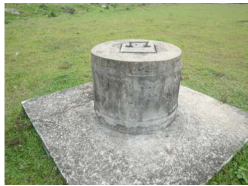
สภาพบ่อติดตามตรวจสอบคุณภาพน้ำใต้ดิน
