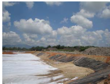
ระบบกำจัดขยะมูลฝอยแบบถูกหลักสุขาภิบาล เทศบาลเมืองสุไหงโก-ลก (อยู่ในระหว่างการก่อสร้าง)
