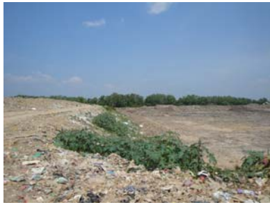
ระบบกำจัดขยะมูลฝอยแบบถูกหลักสุขาภิบาล เทศบาลเมืองพัทลุง
