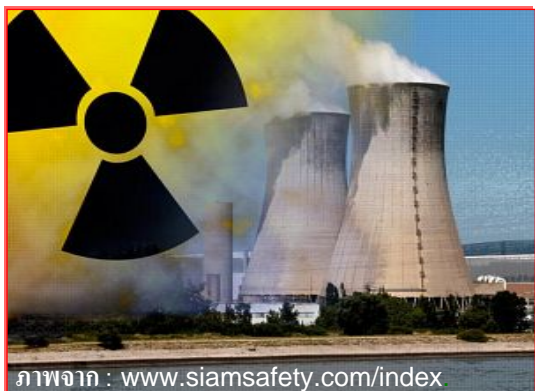
ภาพที่ 61 โรงงานกำจัดขยะที่มีสารกัมมันตภาพรังสี
