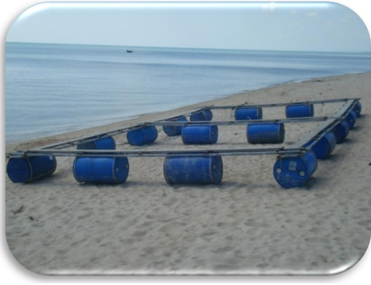
ภาพที่ ๒๓ ซ้าย: แพเลี้ยงปลาแบบโครงเหล็ก และ ขวา: แพแบบ HDPE
