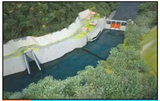
รูปที่ 4 ประตูระบายน้ำและอาคารประกอบ
