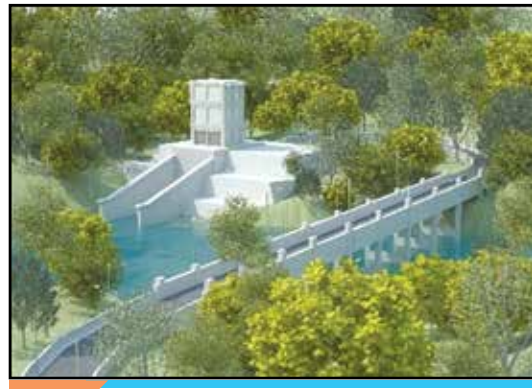
รูปที่ 8 อาคารระบายน้ำท้ายอุโมงค์ส่งน้ำแม่จัด - แม่กวง และถนนเข้าบริเวณอาคารจ่ายน้ำ
