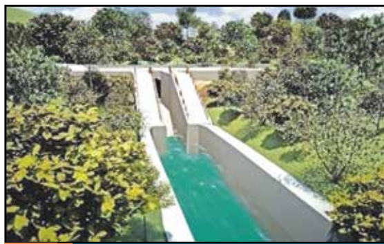
รูปที่ 6 อาคารระบายน้ำท้ายอุโมงค์ส่งน้ำ แม่แดง – แม่จัด
