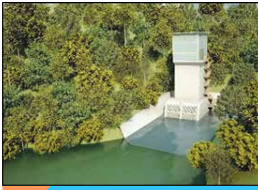
รูปที่ 7 อาคารรับน้ำเข้าอุโมงค์ส่งน้ำ
