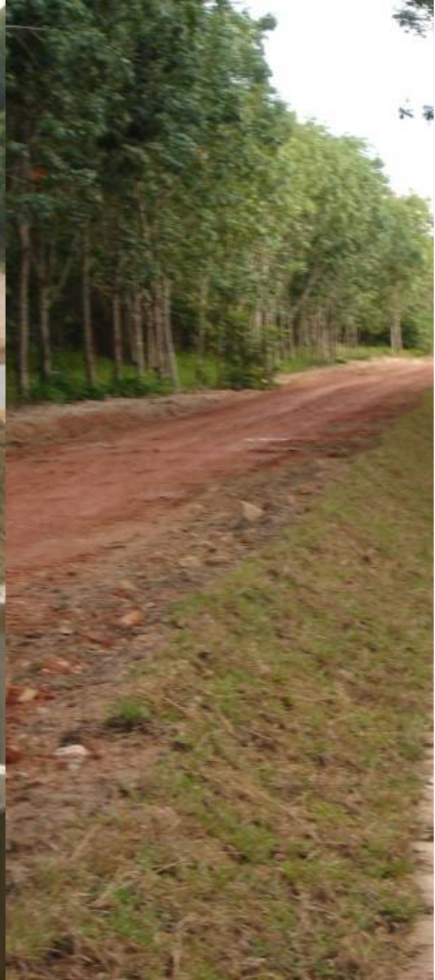
2. ก่อสร้างรางน้ำรูป U - Shape ขนาดกันกว้าง 1.50 เมตร สูง 1.65 เมตร ความยาวรวม 2,796 เมตร
