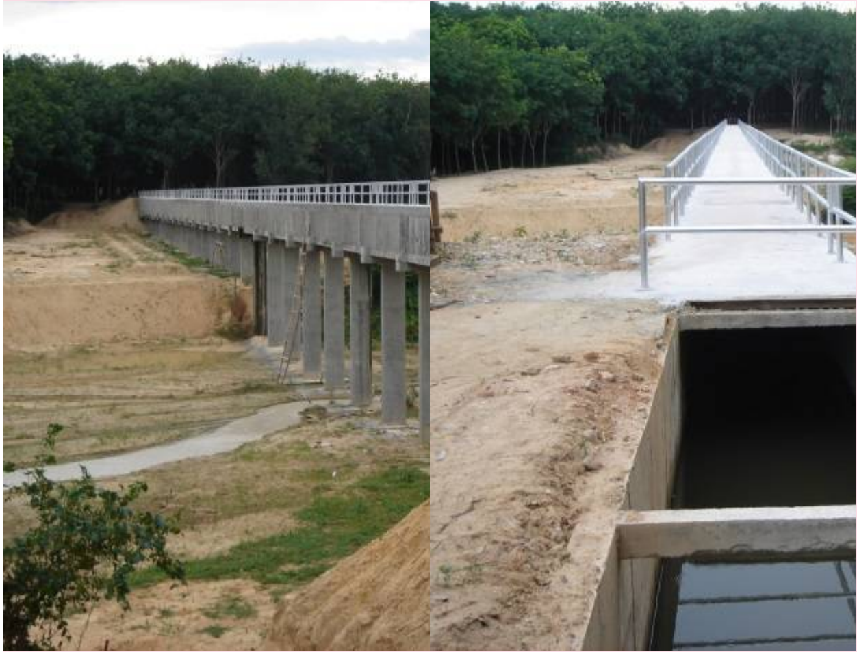
4.) ก่อสร้างสะพานน้ำ (Flume) ขนาดก้นกว้าง 1.50 เมตร สูง 1.65 เมตร ความยาวรวม 192 เมตร
