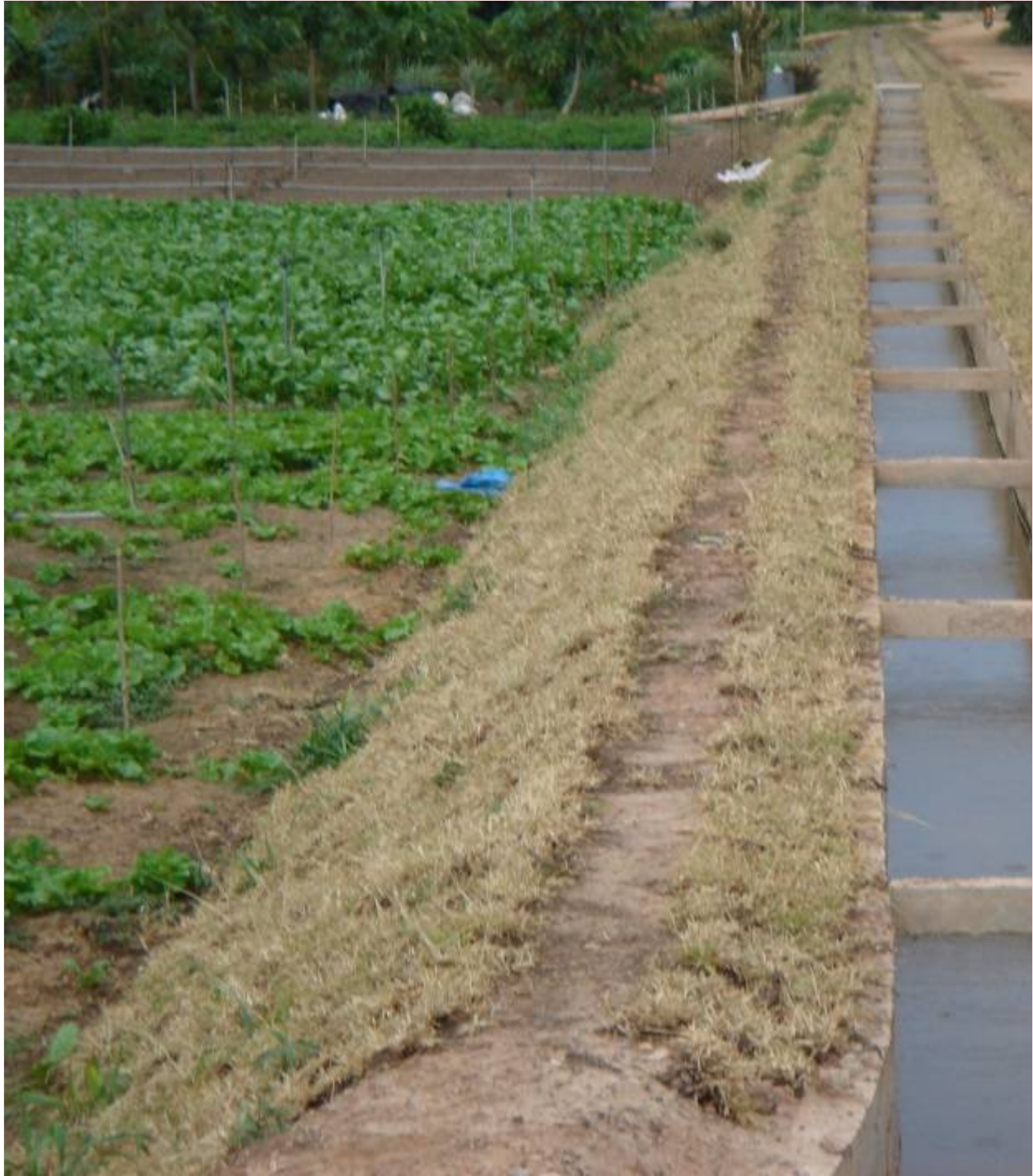
3.) ก่อสร้างรางน้ำรูป U – Shape ขนาดกันกว้าง 0.70 เมตร สูง 0.75 เมตร ความยาวรวม 1,078 เมตร
