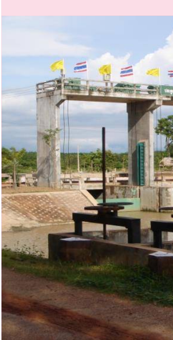
ภาพถ่ายแสดงด้านหลัง ท่อระบายน้ำปากคลองส่งน้ำสายที่ 1 และ 2
