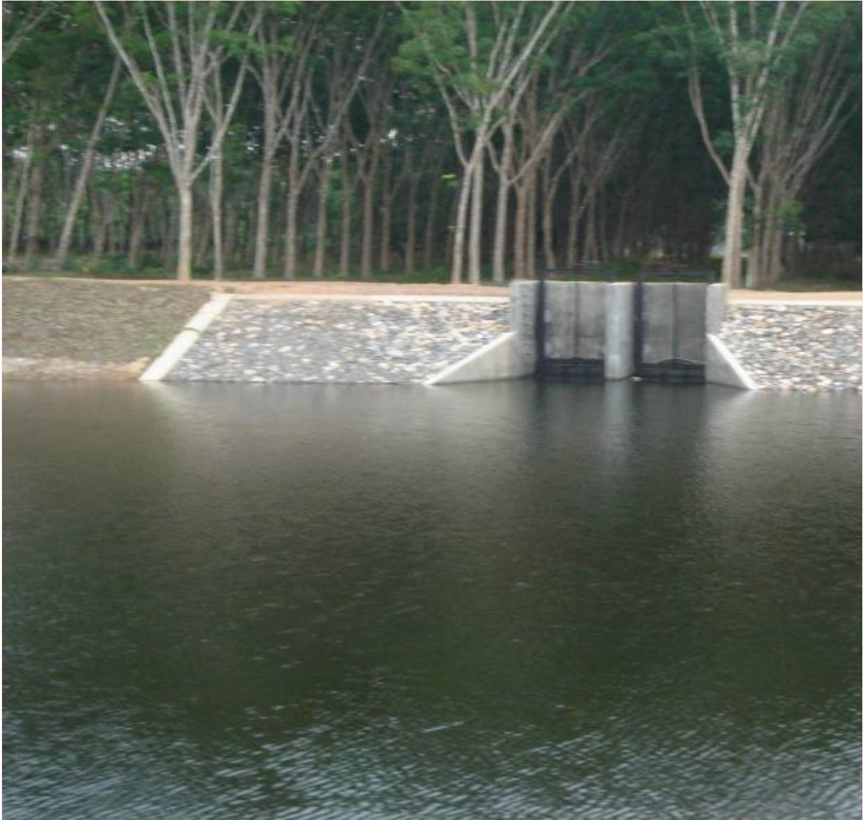
ภาพถ่ายแสดงด้านหน้า ท่อระบายน้ำปากคลองส่งน้ำสายที่ 1 และ 2
