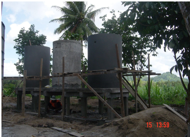
ระหว่างก่อสร้างถึงกรองน้ำ
