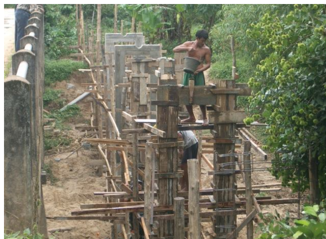
ระหว่างก่อสร้างต่อม่อรับท่อส่งน้ำ
