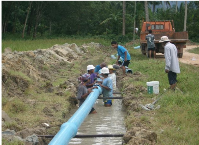
ระหว่างการก่อสร้างท่อส่งน้ำ
