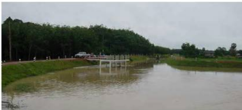
ทรบ.ห้วยปลิง - หนองยางชม ก่อสร้างแล้วเสร็จ
