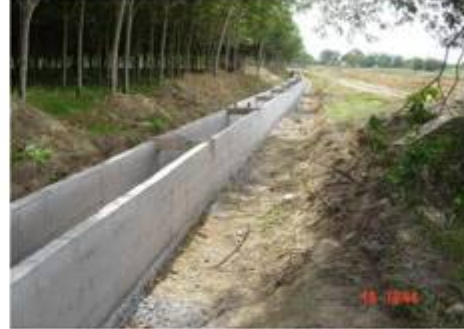
ระหว่างก่อสร้างรางส่งน้ำ 2 ซ้าย - สายใหญ่ฝั่งขวา
