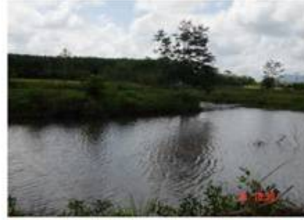
ด้านหน้าท่อระบายน้ำห้วยปลิง - หนองยางชม (เดิม)
