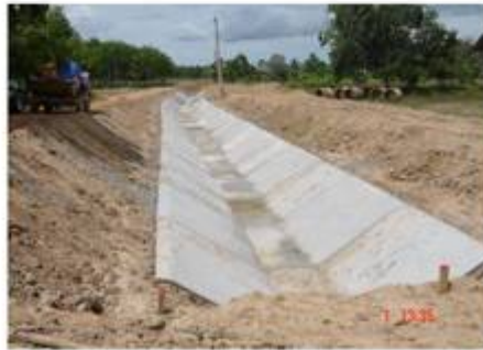
ระหว่างก่อสร้างคลองส่งน้ำสาขาใหญ่ฝั่งขวา
