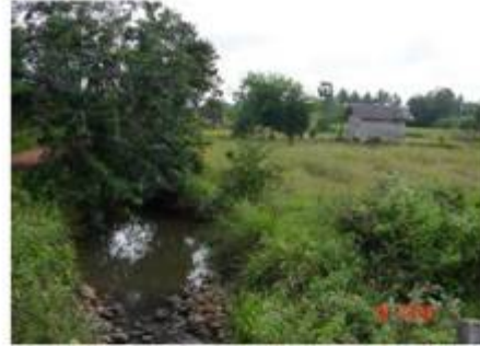
ต้นท่อน้ำท่อระบายน้ำห้วยปลิง - หนองยางชม (เดิม)
