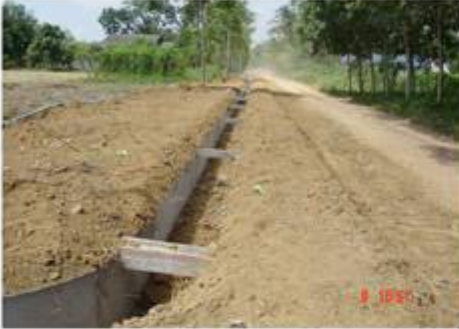
ระหว่างก่อสร้างรางส่งน้ำ 1 ซ้าย - สายใหญ่ฝั่งขวา
