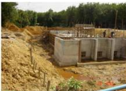
ระหว่างก่อสร้างท่อระบายน้ำห้วยปลิง - หนองยางชม (ใหม่)
