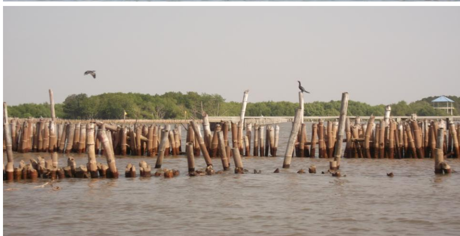
ภาพที่ 2.11 การปักไม้ไผ่ชะลอคลื่นเพื่อลดการกัดเซาะชายฝั่งในตำบลพันท้ายนรสิงห์และตำบล
