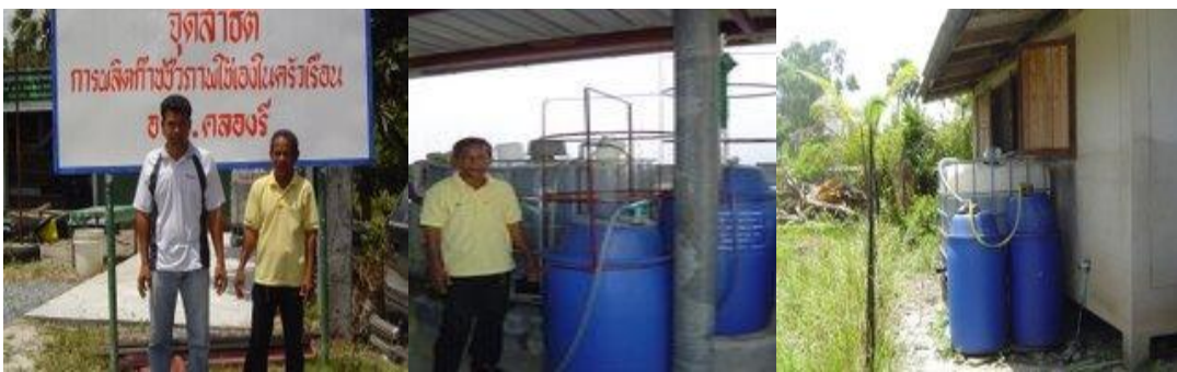
แผนภาพที่ 3.8 แสดงการจัดการน้ำเสียจากฟาร์มสุกรโดยบ่อหมักแก๊สชีวภาพชุมชน
