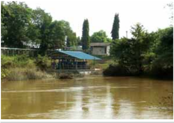
^ ด้านหลังของโรงงานแห่งหนึ่งที่มองเห็นโรงสูบน้ำ
