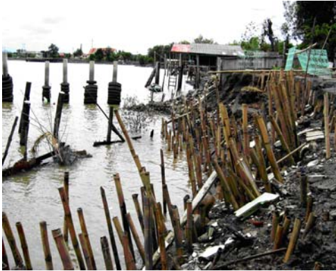
ภาพที่ 22 ตรวจสอบการพังทลายของตลิ่งในรัศมี 100 เมตร ว่ามีผลกระทบจากการขุดลอกหรือไม่
