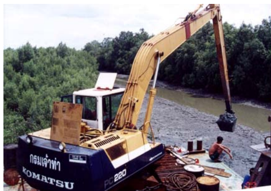
ภาพที่ 37 การวางแผนการปฏิบัติงานขุดลอกร่องน้ำขนาดเล็ก
