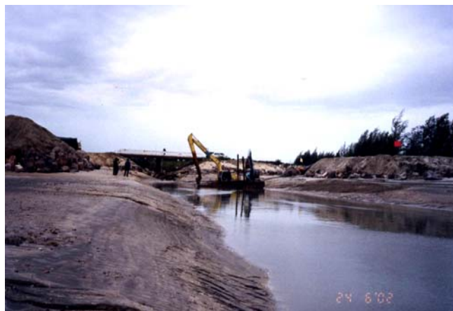
ภาพที่ 51 การขุดลอกร่องน้ำและที่ทิ้งดิน
