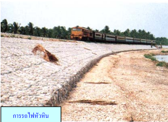
กล่องแกเบียนเคลือบสังกะสีหุ้มด้วยพีวีซี ป้องกันการกัดกร่อนได้อย่างมีประสิทธิภาพ
