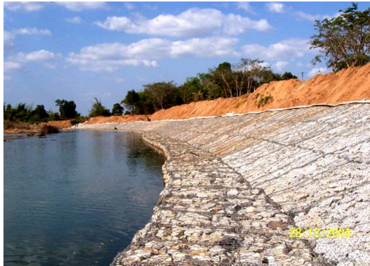
ภาพที่ 68 ตัวอย่างของเขื่อนประเภทหินเรียงในคลองลวดตาข่าย
