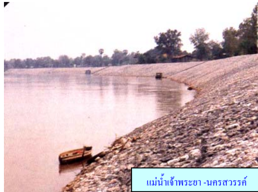
กล่องแกเบียนเคลือบสังกะสีหุ้มด้วยพีวีซี ป้องกันการกัดกร่อนได้อย่างมีประสิทธิภาพ
