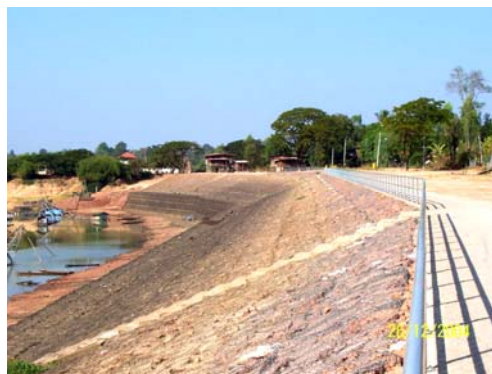
ภาพที่ 72 ภาพเขื่อนป้องกันตลิ่งด้านบนเป็นทางเดินและปรับภูมิทัศน์
