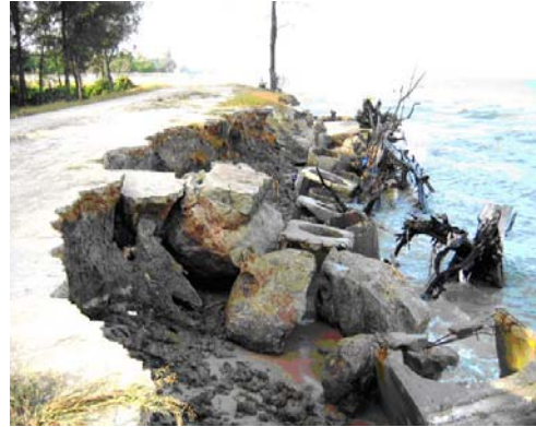
ภาพที่ 22 ตรวจสอบการพังทลายของตลิ่งในรัศมี 100 เมตร ว่ามีผลกระทบจากการขุดลอกหรือไม่
