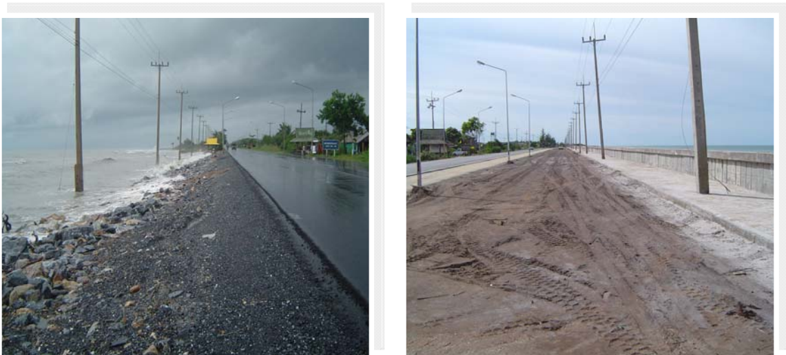
รูปที่ 3.51 กำแพงป้องกันคลื่นน้ำทะเลกัดเซาะคันทางโครงการที่ 2 ระหว่าง กม. 16+060-17+034 (ก่อสร้างแล้วเสร็จเมื่อวันที่ 27 พ.ค. 2550)
