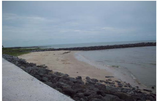
รูปที่ 4.21 การสร้างเขื่อนหินนอกชายฝั่ง และเขื่อนหินรูปตัวทีของกรมเจ้าท่าที่มีบางส่วนเกิดการกลับมาของตะกอนทรายด้านหลังของเขื่อนหิน
