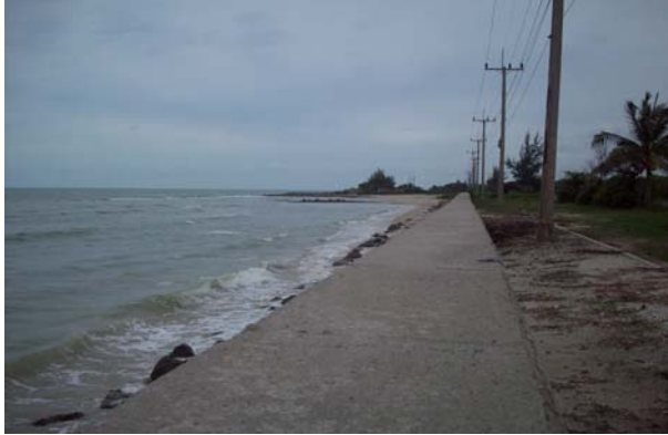
รูปที่ 4.23 การก่อสร้างกำแพงป้องกันคลื่นตามแนวทางหลวงหมายเลข 4013 ของกรมทางหลวงตั้งแต่ปี 2549-2551 ความยาวประมาณ 4000 เมตร
