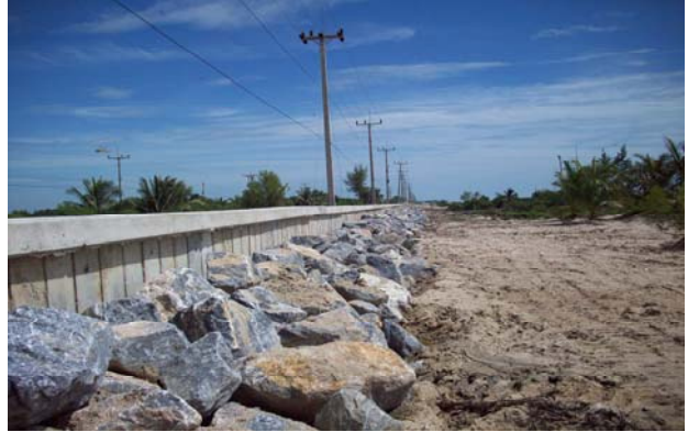
รูปที่ 4.23 การก่อสร้างกำแพงป้องกันคลื่นตามแนวทางหลวงหมายเลข 4013 ของกรมทางหลวงตั้งแต่ปี 2549-2551 ความยาวประมาณ 4000 เมตร
