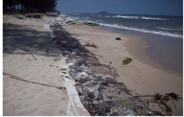
รูปที่ 4.20 การใช้กล่องตาข่ายใส่หิน ตาข่ายสูญเสียหายจากน้ำทะเล ก้อนหินที่ใส่ถูกคลื่นกระแทกและเขย่าจนบางส่วนหลุดออกจากกล่องตาข่าย
