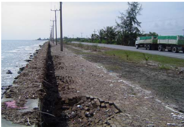
รูปที่ 4.24 กำแพงของคลื่นปะทะเข้ากับกำแพงกันคลื่นตามแนวทางหลวงหมายเลข 4013 เกิดการข้ามล้นของคลื่นและน้ำเหนือสันกำแพง เนื่องจากหน้ากำแพงมีความลึก หรือมีความชันมาก
