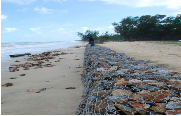
รูปที่ 4.20 การใช้กล่องตาข่ายใส่หิน ตาข่ายสูญเสียหายจากน้ำทะเล ก้อนหินที่ใส่ถูกคลื่นกระแทกและเขย่าจนบางส่วนหลุดออกจากกล่องตาข่าย
