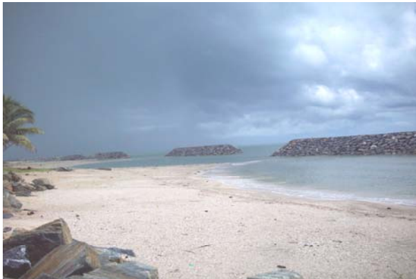
รูปที่ 4.21 การสร้างเขื่อนหินนอกชายฝั่ง และเขื่อนหินรูปตัวทีของกรมเจ้าท่าที่มีบางส่วนเกิดการกลับมาของตะกอนทรายด้านหลังของเขื่อนหิน
