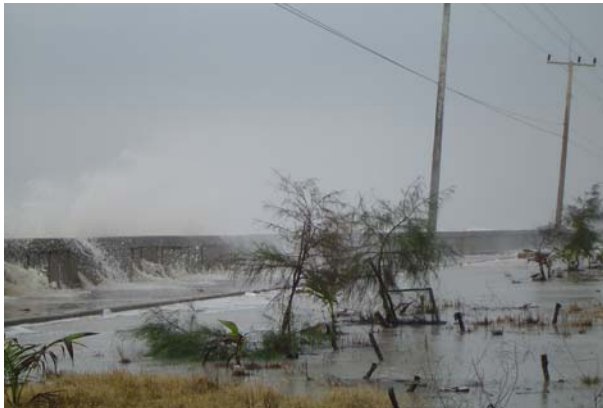
รูปที่ 4.24 กำแพงของคลื่นปะทะเข้ากับกำแพงกันคลื่นตามแนวทางหลวงหมายเลข 4013 เกิดการข้ามล้นของคลื่นและน้ำเหนือสันกำแพง เนื่องจากหน้ากำแพงมีความลึก หรือมีความชันมาก
