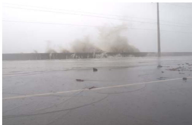
รูปที่ 4.24 กำแพงของคลื่นปะทะเข้ากับกำแพงกันคลื่นตามแนวทางหลวงหมายเลข 4013 เกิดการข้ามล้นของคลื่นและน้ำเหนือสันกำแพง เนื่องจากหน้ากำแพงมีความลึก หรือมีความชันมาก
