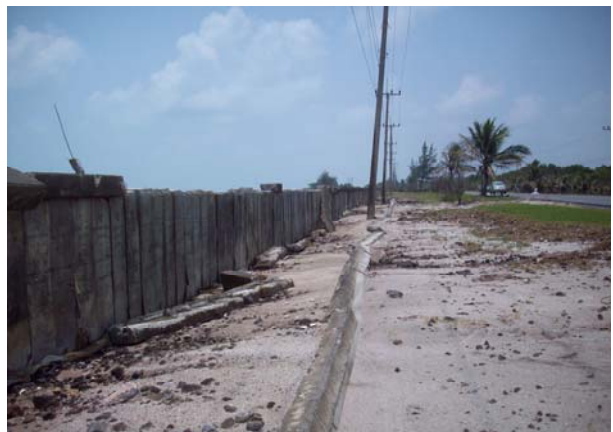
รูปที่ 4.24 กำแพงของคลื่นปะทะเข้ากับกำแพงกันคลื่นตามแนวทางหลวงหมายเลข 4013 เกิดการข้ามล้นของคลื่นและน้ำเหนือสันกำแพง เนื่องจากหน้ากำแพงมีความลึก หรือมีความชันมาก
