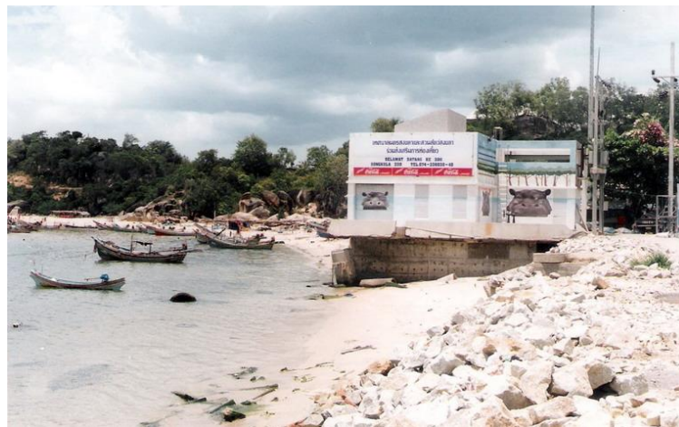
หลังก่อสร้างสถานสูบน้ำเสียบริเวณหาดชลาทศน์ ปี พ.ศ.2543
