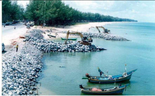
ก่อสร้างรอดักทราย(Groin) จำนวน 3 ตัว
