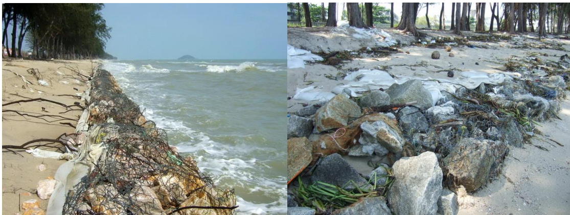
ก่อสร้างโครงสร้างป้องกันการกัดเซาะด้วยกล่องบรรจุหิน (Gabion) ในปี 2551
