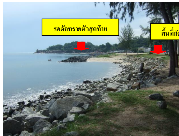
บริเวณด้านเหนือของรอดักทรายตัวสุดท้ายมีการกัดเซาะรุนแรง
