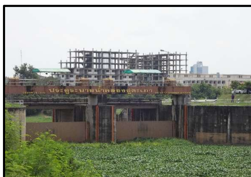
ภาพประกอบ 43 ประตุน้ำระบายน้ำคลองอุ้ตะเภา (ควบคุมการปล่อยน้ำจากคลองอุ้ตะเภาลงสู่คลองอุ้ตะเภาช่วงที่ผ่านเทศบาลนครหาดใหญ่)
