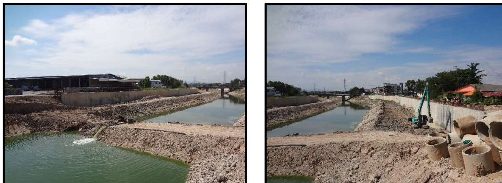
ภาพประกอบ 12 การก่อสร้างขยายคลองระบายน้ำที่ 1 เทศบาลนครหาดใหญ่
