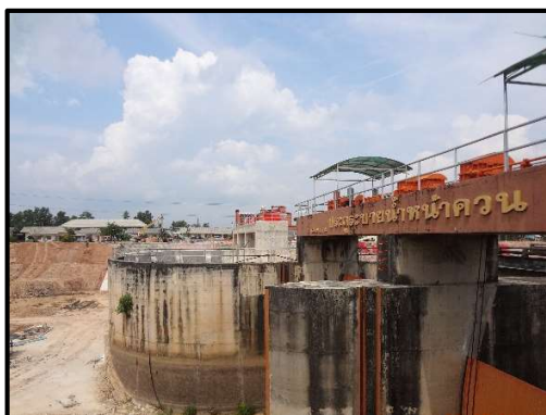
ภาพประกอบ 44 ประตูระบายน้ำหน้าควน (ควบคุมการปล่อยน้ำจากคลองอยู่ตะเภากลางสู่คลองระบายน้ำที่ 1)
