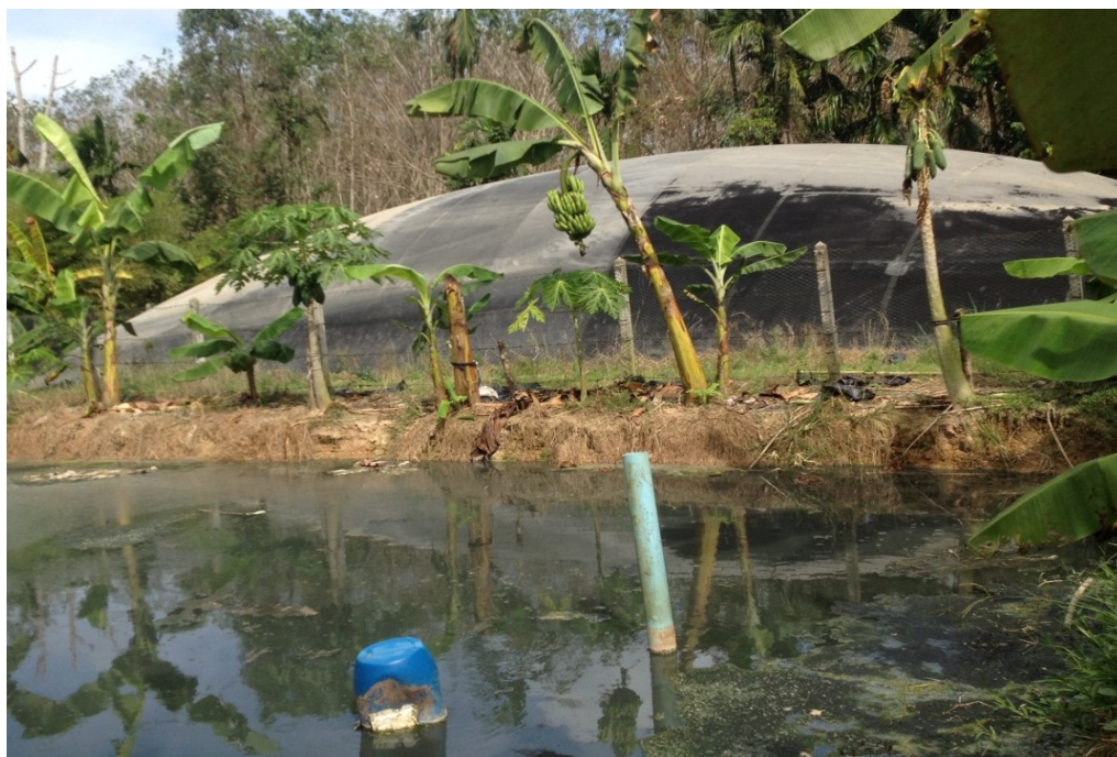
ภาพที่ 4.29 บ่อหมักไบโอแก๊สของสหกรณ์กองทุนสวนยางบ้านเก่าร้าง
