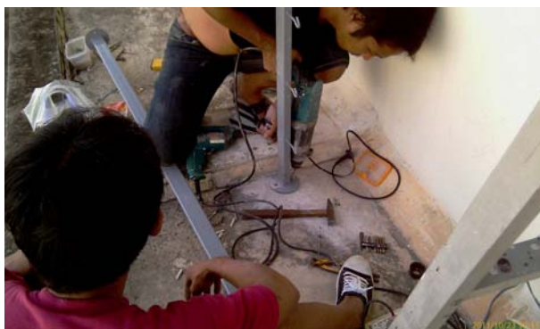
รูปที่ 3-18 การติดตั้งโครงเหล็ก Plate ด้วยน็อตยึด
