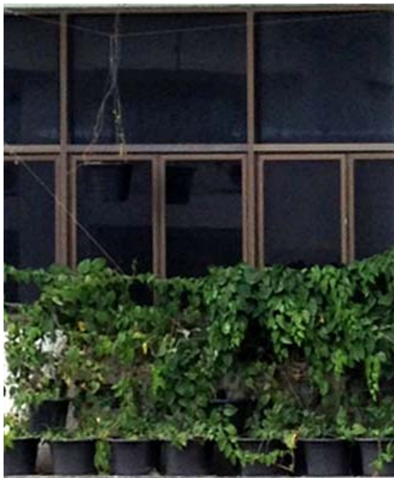
รูปที่ 4-2 ต้นมันบาดลิที่ปกคลุมผนังอาคารที่บหลังจากทดลองปลูกเป็นระยะเวลา 2 เดือน
