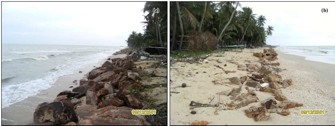
รูปที่ 3-16 แนวหินทิ้งป้องกันคลื่น บ้านหัวทรง (a) และบ้านหนองมนต์ (b) ดำเนินการโดย สำนักงานจังหวัดนครศรีธรรมราช
