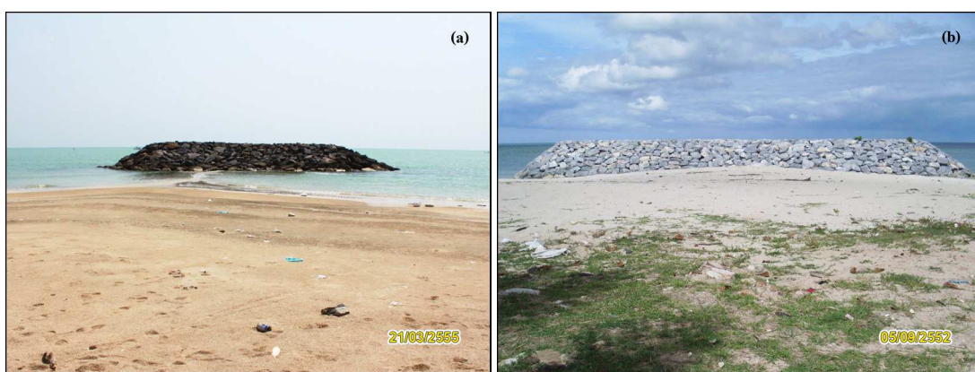
รูปที่ 3-8 เขื่อนกันคลื่นนอกชายฝั่งขนาดเล็ก บ้านนำทรัพย์ (a) และเขื่อนกันคลื่นนอกชายฝั่งบ้านบ่อคณทิ (b) ดำเนินการก่อสร้างโดยกรมเจ้าท่า
