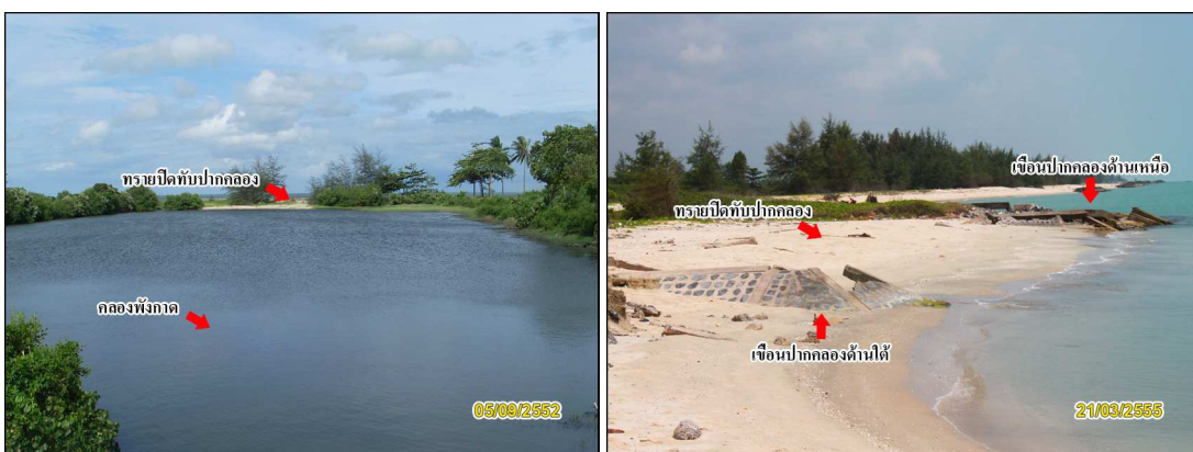
รูปที่ 3-5 สภาพคลองพังทลาย มีทรายปิดทับปากคลอง ไม่สามารถใช้ประโยชน์ในการระบายน้ำได้
