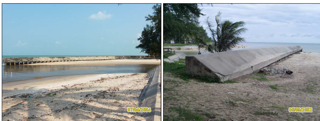
รูปที่ 3-34 เขื่อนกันทรายปากคลองระบายน้ำป่ากระวะ ดำเนินการก่อสร้างโดยกรมชลประทาน
