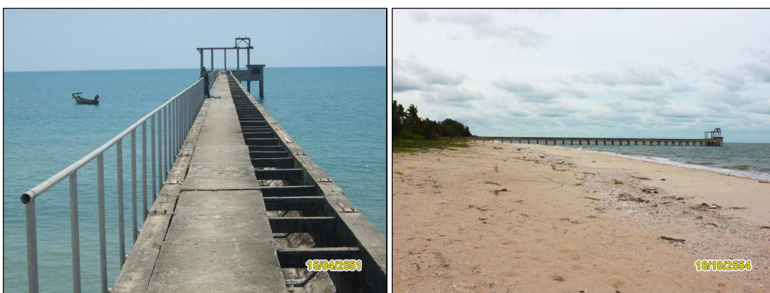
รูปที่ 3-32 ท่อสูบน้ำขนาดใหญ่ ดำเนินการก่อสร้างโดยบริษัทเอกชน
