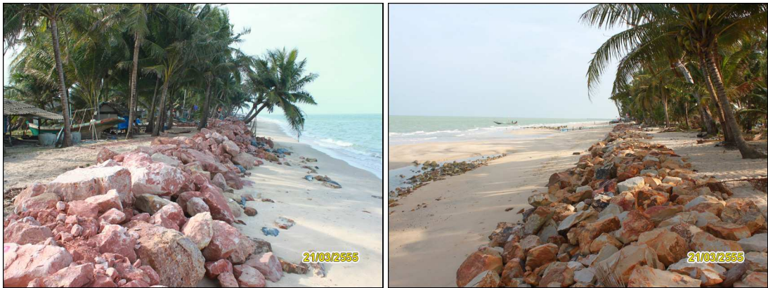
รูปที่ 3-47 แนวหินทิ้งป้องกันคลื่น บริเวณบ้านหน้าศาลเหนือ
