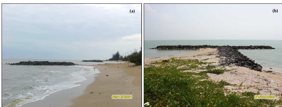
รูปที่ 3-7 รอดักทรายรูปตัวไอ (a) และรอดักทรายรูปตัวที (b) ดำเนินการก่อสร้างโดยกรมเจ้าท่า
