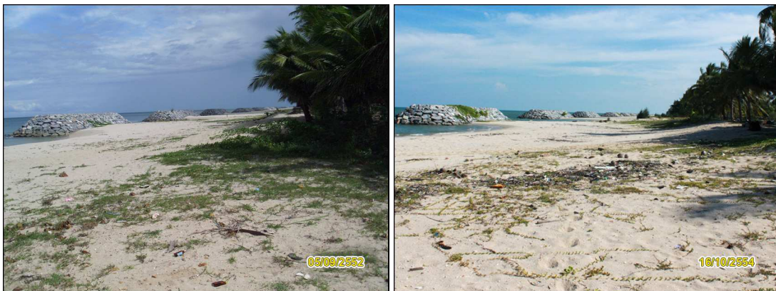
รูปที่ 3-22 สภาพชายฝั่งบริเวณบ้านเกาะเพชร มีการสะสมทรายหลังเขื่อนกันคลื่นนอกชายฝั่ง
