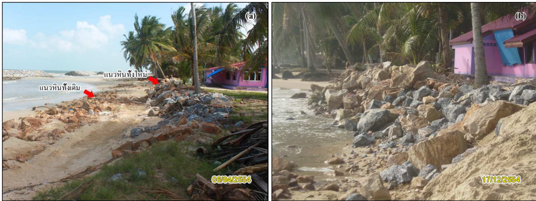
รูปที่ 3-19 แนวหินทิ้งป้องกันคลื่น หลังมัสยิดบ้านหนองมนต์ สร้างเมื่อปี พ.ศ. 2552 (a) และเมื่อปี พ.ศ. 2554 (b) ดำเนินการโดยเทศบาลตำบลเกาะเพชร
