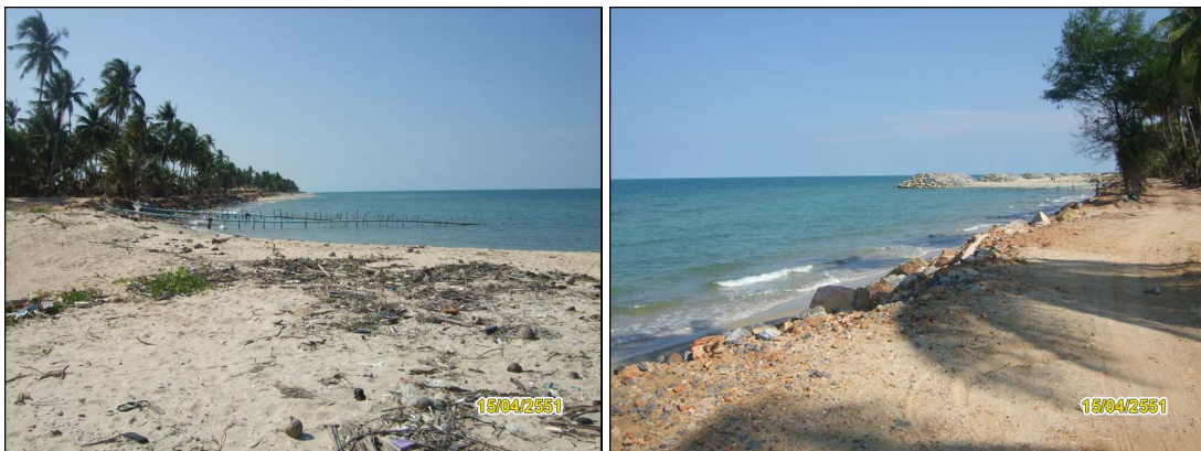
รูปที่ 3-25 สภาพชายฝั่งด้านเหนือเชื่อมกันคลื่นนอกชายฝั่ง บริเวณบ้านหัวทรง
