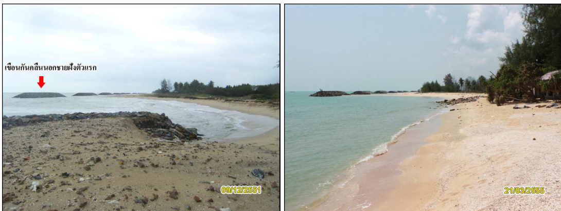
รูปที่ 3-10 สภาพชายฝั่งด้านใต้ เขื่อนกันทรายปากคลองพังกาด บ้านบ่อคณทิ
