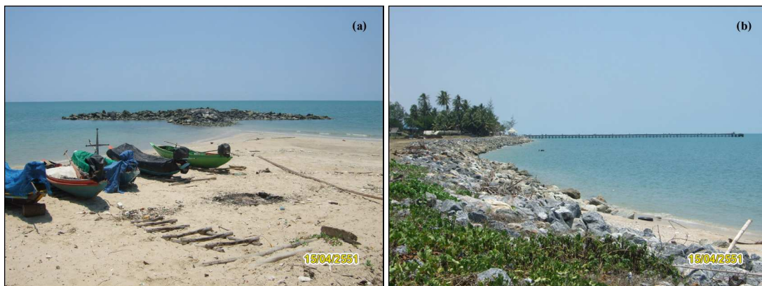
รูปที่ 3-38 รอดักทรายรูปตัวที (a) และแนวหินทิ้งป้องกันคลื่น (b) ก่อสร้างโดยกรมชลประทาน
