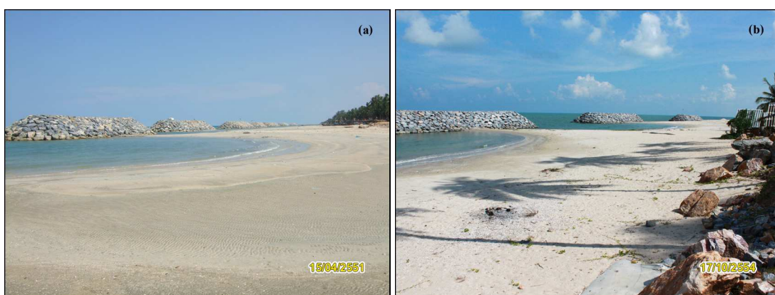
รูปที่ 3-40 เขื่อนกันคลื่นนอกชายฝั่ง บ้านหน้าสวน (a) และหาดจันทร์แจ้ง (b) ดำเนินการก่อสร้าง โดยกรมเจ้าท่า
