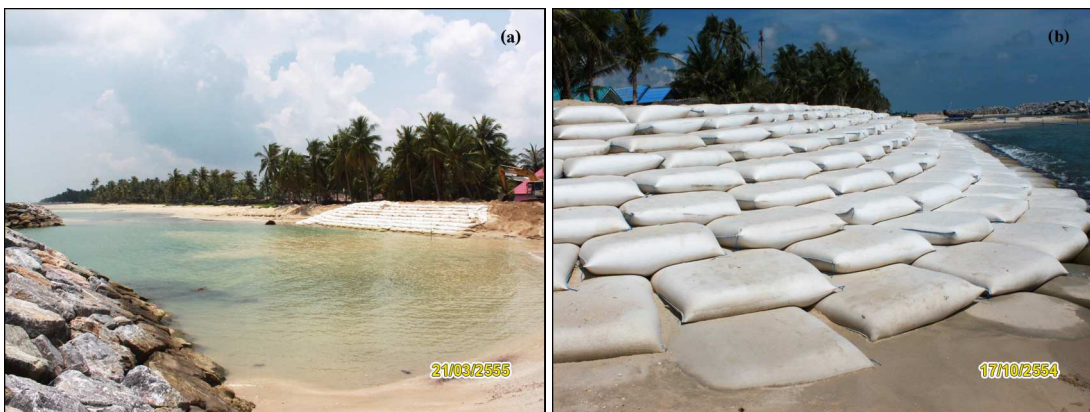
รูปที่ 3-20 กำแพงอุทธราย บริเวณบ้านหนองมนต์ (a) และบ้านหัวทรง (b) ดำเนินการก่อสร้างโดยกรมเจ้าท่า
