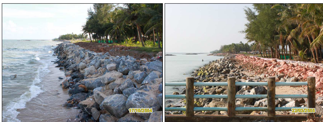
รูปที่ 3-45 แนวหินทิ้งป้องกันตลิ่ง วางถัดจากกำแพงคอนกรีต บ้านหน้าศาลใต้
