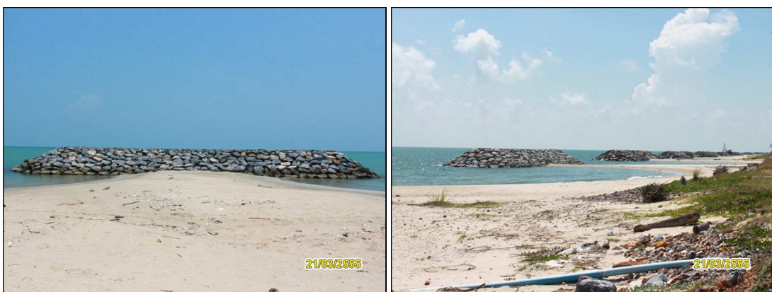
รูปที่ 3-18 เขื่อนกันคลื่นนอกชายฝั่ง ดำเนินการก่อสร้างโดยกรมเจ้าท่า
