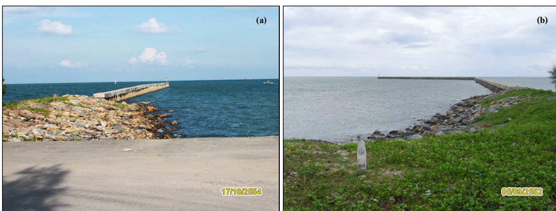
รูปที่ 3-31 เขื่อนกันทรายปากคลองระบายน้ำชะอวด-แพรงเมือง ด้านเหนือ (a) และด้านใต้ (b) ดำเนินการก่อสร้างโดยกรมชลประทาน
