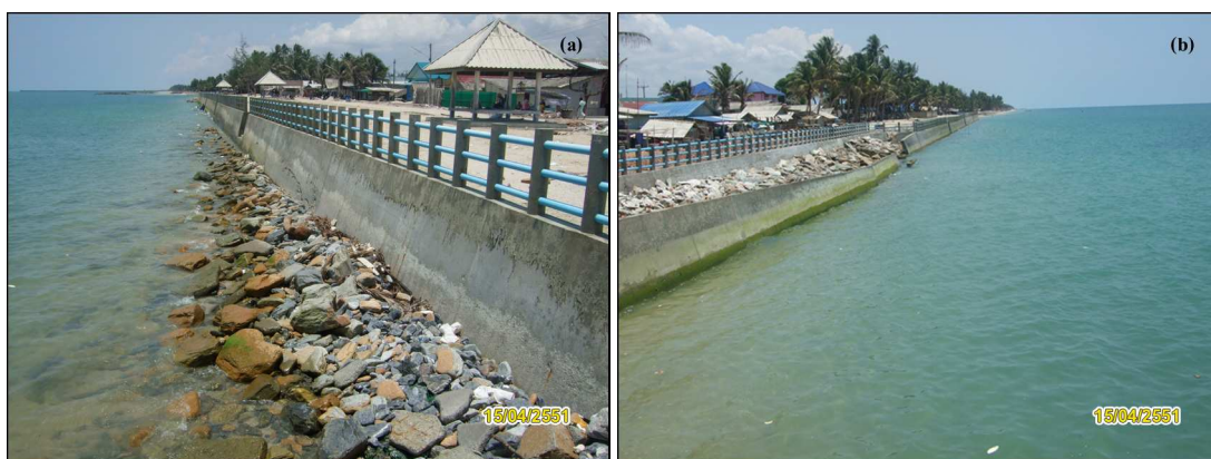
รูปที่ 3-37 กำแพงคอนกรีต บริเวณบ้านหน้าศาลใต้ (a) และบ้านหน้าศาลเหนือ (b) ดำเนินการก่อสร้างโดยกรมโยธาธิการและผังเมือง
