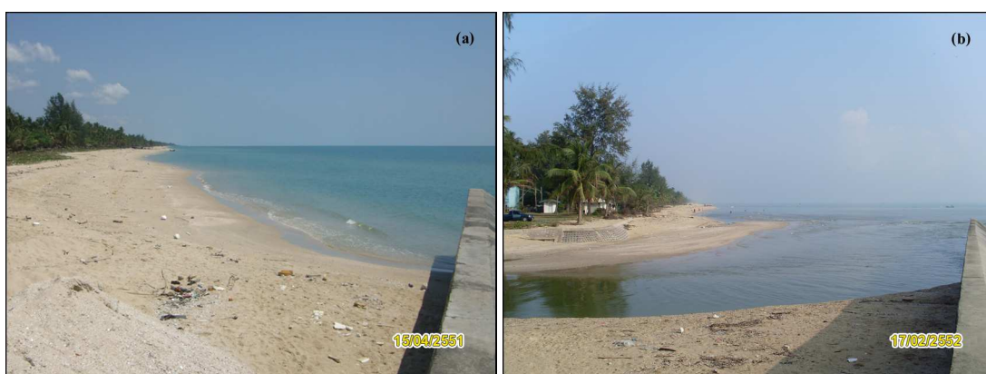
รูปที่ 3-35 สภาพทรายปิดทับปากคลอง (a) และทรายเคลื่อนตัวออก (b) คลองระบายน้ำป่ากระวะ
