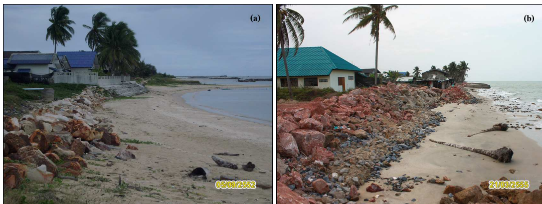
รูปที่ 3-39 แนวหินทิ้งป้องกันคลื่น บ้านแพรงเมือง (a) ดำเนินการ โดยสำนักงานจังหวัดนครศรีธรรมราช และบ้านหน้าศาลเหนือ (b) ดำเนินการ โดยองค์การบริหารส่วนตำบลหน้าสวน
