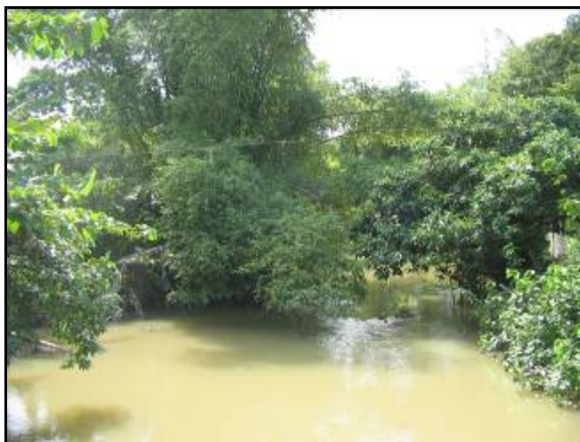
ข. บริเวณสะพาน คสล. บ้านตำนาน อำเภอเมือง จังหวัดพัทลุง
