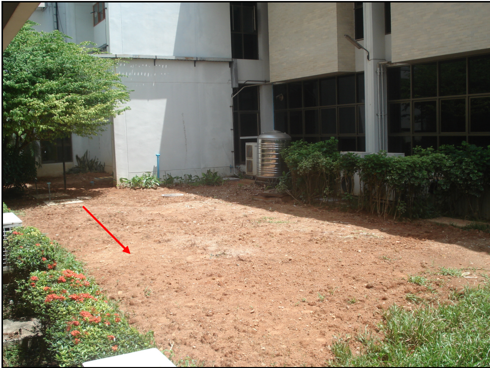
ภาพประกอบที่ 8 ระบบบำบัดน้ำเสียของสำนักงานอธิการบดี ฝั่งบริเวณอาคาร 1 และอาคาร 2 ของสำนักงานอธิการบดี
