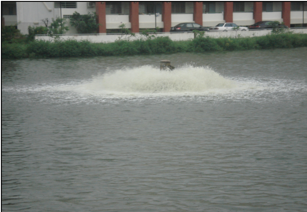
ภาพประกอบที่ 11 ลักษณะของป่อเติมอากาศของระบบบำบัดน้ำเสียโรงพยาบาลสงขลานครินทร์
