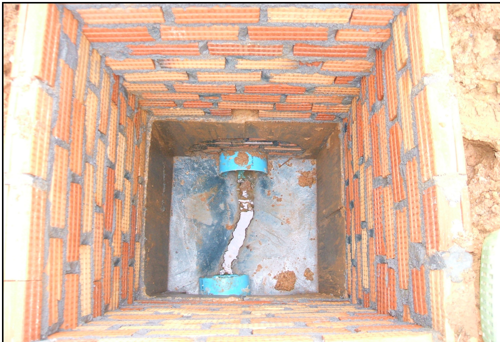
ภาพประกอบที่ 9 นำออกจากระบบบำบัดน้ำเสียของสำนักงานอธิการบดี
