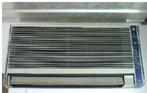
รูปที่ 4.1 เครื่องปรับอากาศแบบแยกส่วน
