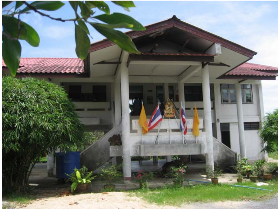
รูปที่ จ - 5 แสดงบริเวณสถานที่เจาะสำรวจดิน BH-4 สถานีอนามัยบ้านบางแรด ม.1 ต.บ้านเพ็ง อ.ปากพนัง จ.นครศรีธรรมราช
