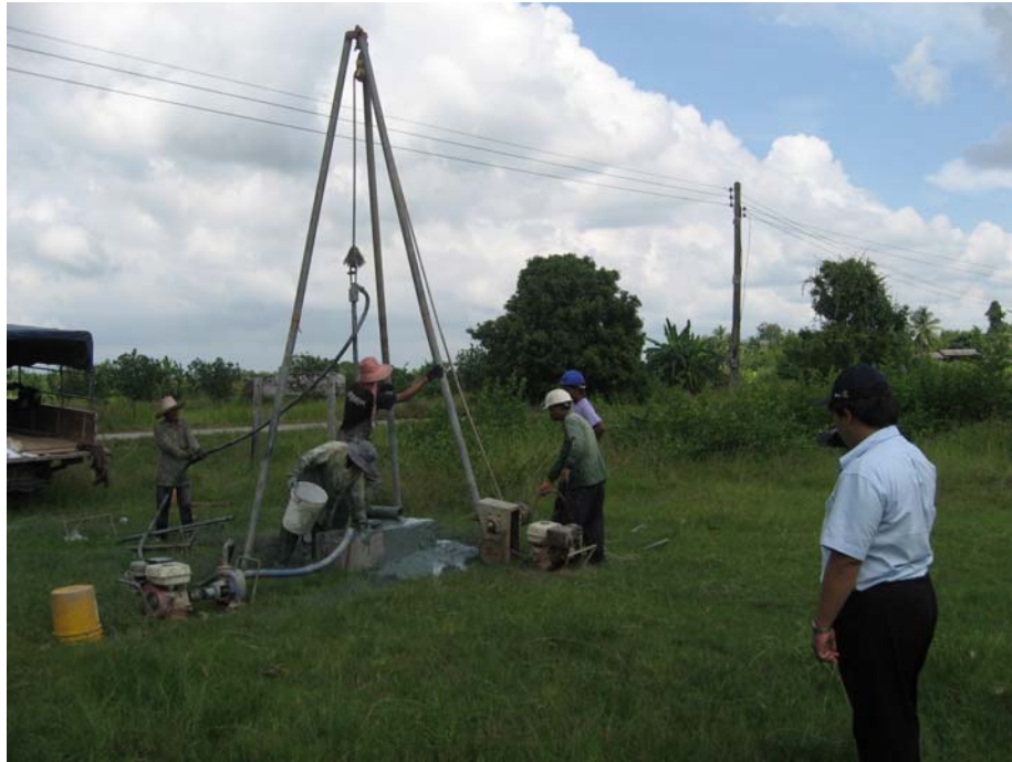
รูปที่ จ – 15 แสดงการเจาะสำรวจดินบริเวณ BH – 5 โรงเรียนบ้านปากคลอง
