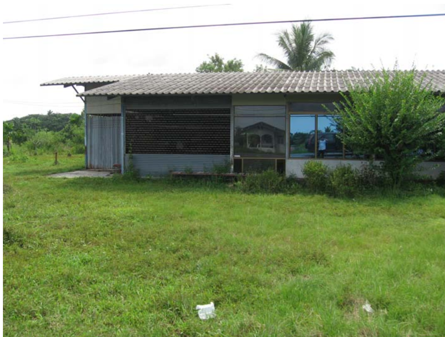
รูปที่ จ – 11 แสดงบริเวณสถานที่เจาะสำรวจดิน BH – 7 กม.18 ทางหลวงหมายเลข 4013 ต.คลองน้อย อ.ปากพนัง จ.นครศรีธรรมราช
