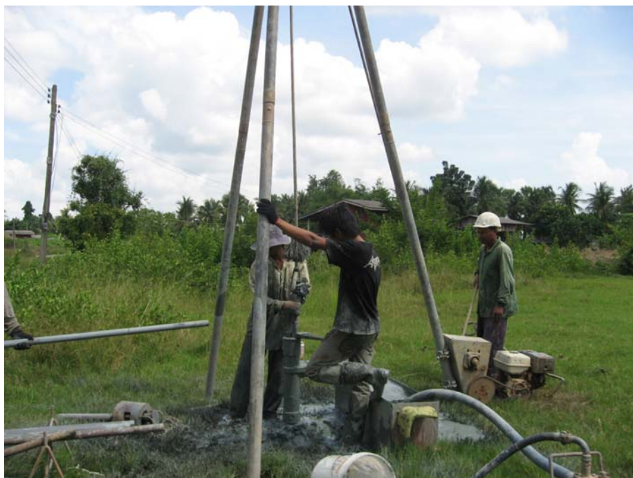
รูปที่ จ – 16 แสดงการเจาะสำรวจดินบริเวณ BH – 5 โรงเรียนบ้านปากคลอง
