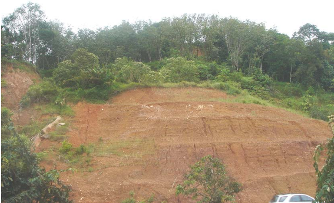
รูปที่ 3.8 ลาดดินหลังการซ่อมแซมในปี พ.ศ. 2548
