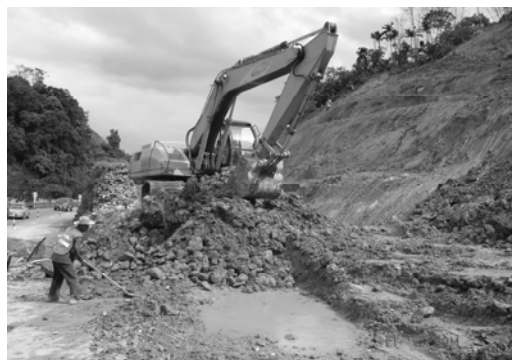
รูปที่ 4 การแก้ไขการวิบัติและปรับแต่งลาดดิน
