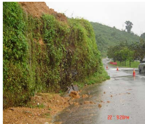
รูปที่ 3 การพิบัติของลาดดิน
