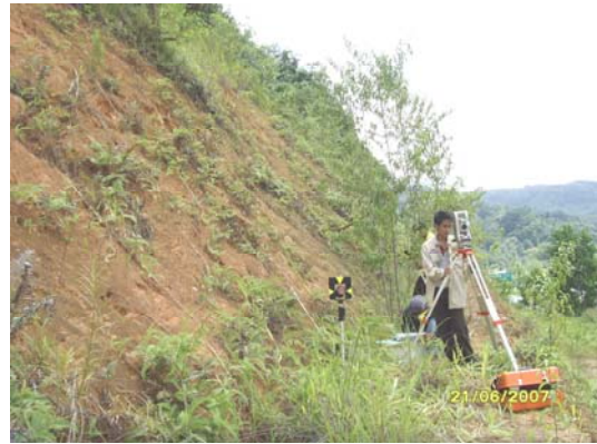
(ข) ขณะตั้งกล้องด้านบนลาดดิน
