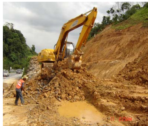
รูปที่ 4 การแก้ไขการพิบัติและปรับแต่งลาดดิน
