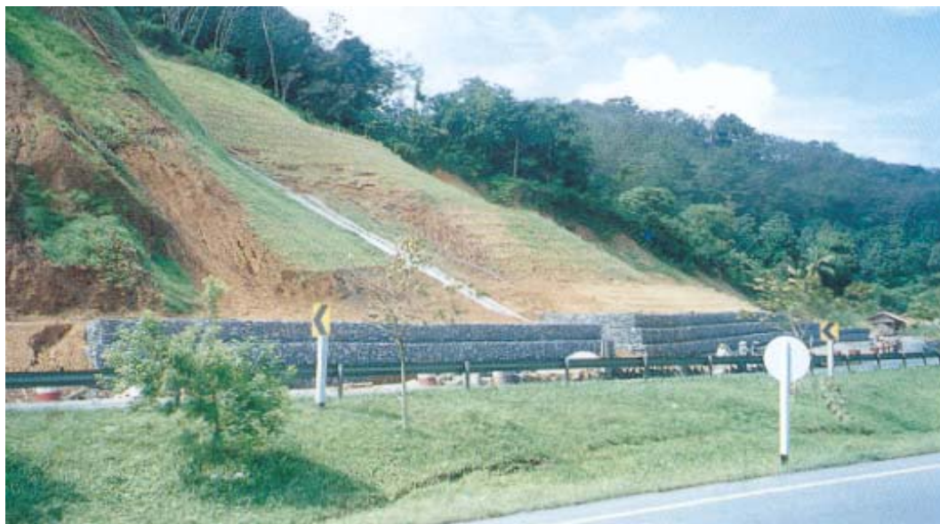
รูปที่ 3.6 ลาดดินหลังการซ่อมแซมในปี พ.ศ. 2544
