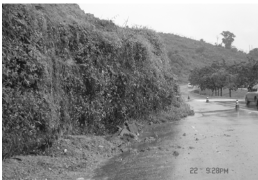
รูปที่ 3 การวิบัติของลาดดิน
