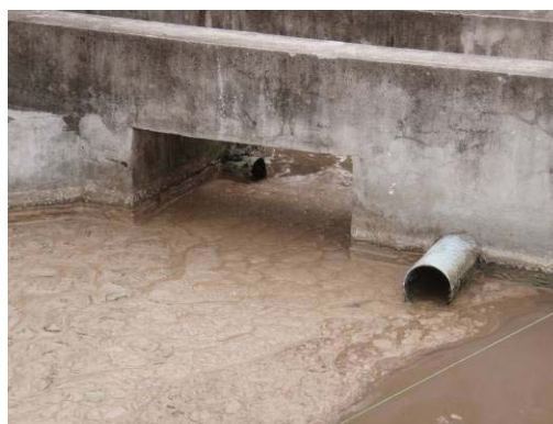
ภาพที่ 3.8 ช่องเปิดของบ่อกระบวนการไนตริฟิเคชันและบ่อกระบวนการดีไนตริฟิเคชัน
