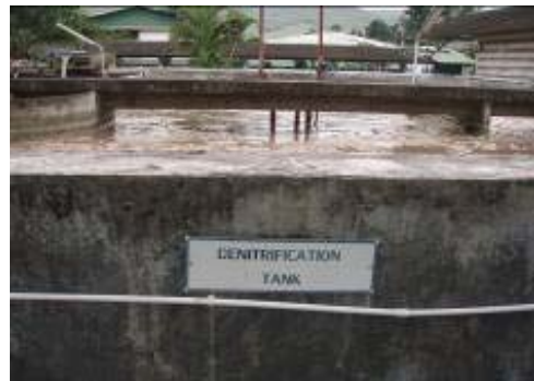
ภาพที่ 3.5 บ่อกระบวนการดีไนตริฟิเคชัน
