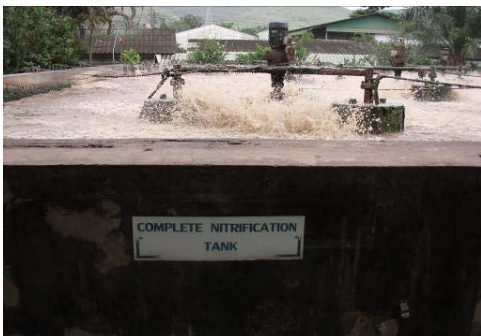
ภาพที่ 3.4 บ่อกระบวนการไนตริฟิเคชัน
