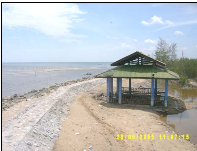
ข. หารัฐตมกษกหลังจาก การก่อสร้างกำแพงกันคลื่น ป้องกันการกัดเซาะ ใน ปี พ.ศ. 2548
