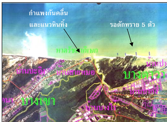
ข. กำแพงกันคลื่นและแนวหินทิ้งบริเวณหาดรีซำ
