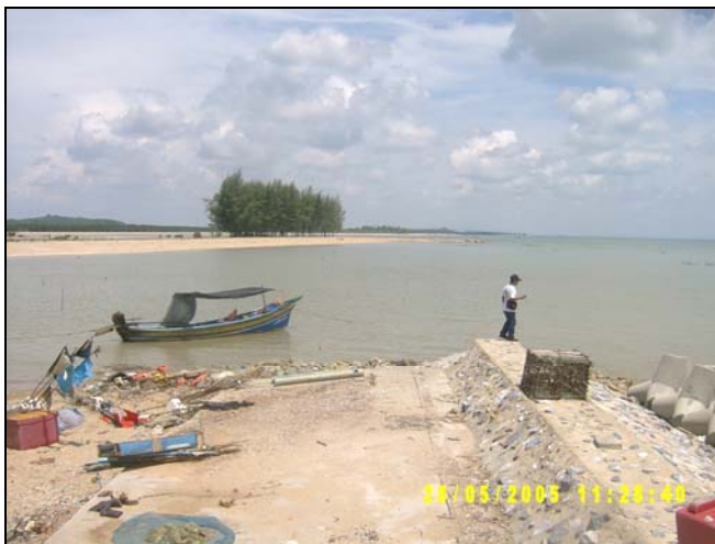
ข. สภาพการกัดเซาะ บริเวณชายฝั่งตอนบน ของกำแพงกันคลื่น บ้านบางตา
