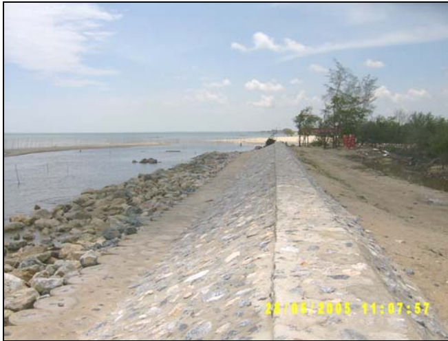
ก. กำแพงกันคลื่นซึ่งก่อสร้าง ปิดทาดรัชดาภิเชก เพื่อป้องกันการกัดเซาะ ชายฝั่ง บริเวณบ้านสายหมอ
