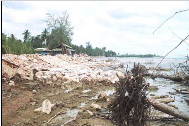
ก. หารัฐตมกษกกำลัง ดำเนนการก่อสร้างกำแพง กันคลื่นป้องกันการกัดเซาะ ใน ปี พ.ศ. 2547
